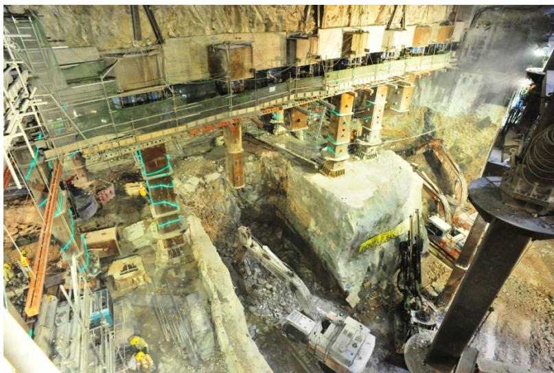
金鐘站港島綫隧道支撐架工程
