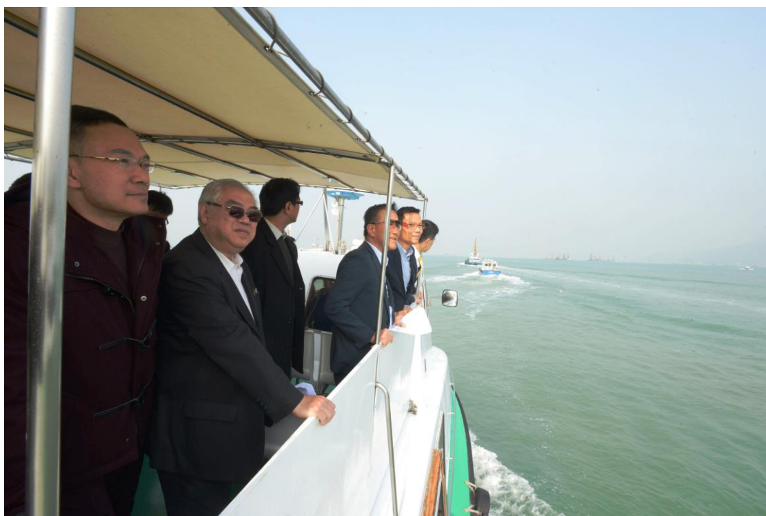
立法會議員在船上視察港珠澳大橋香港口岸填海工程。
