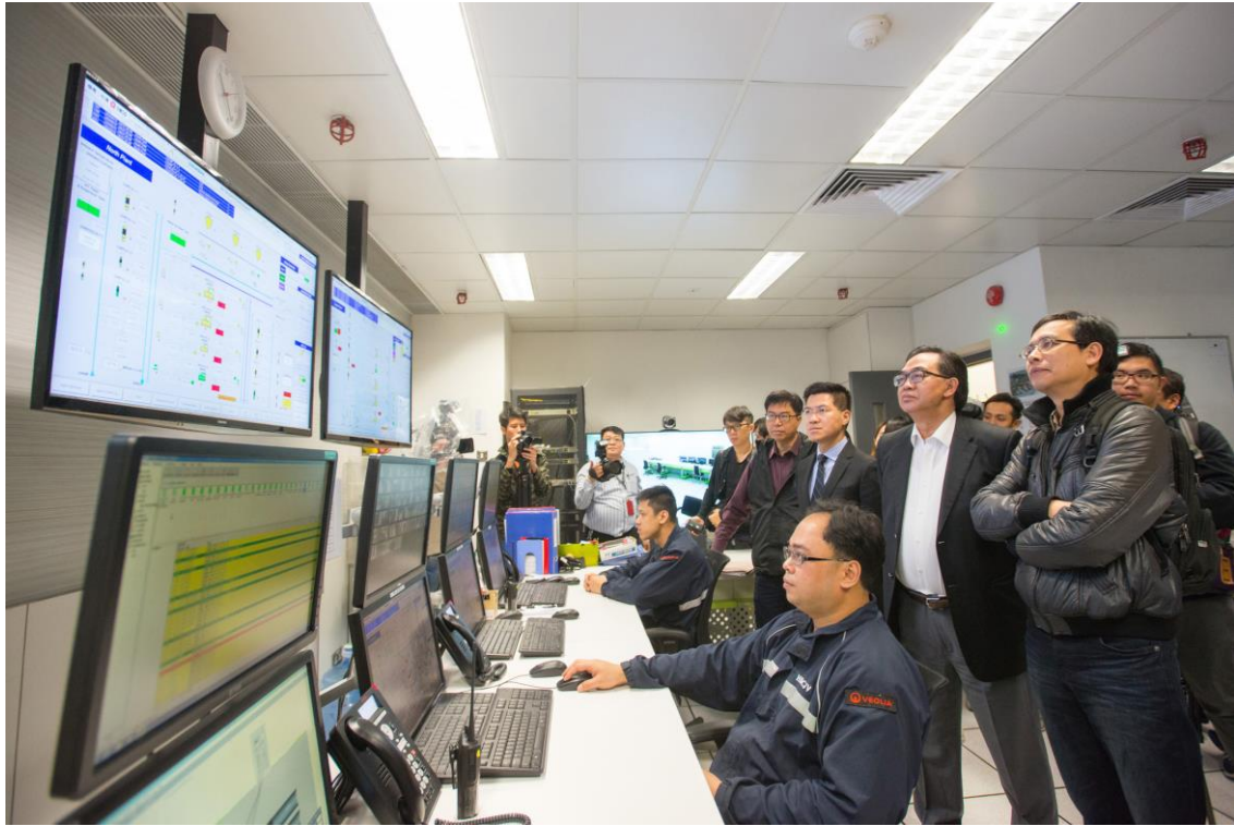
立法會議員視察啟德發展區區域供冷系統北廠的控制室。
