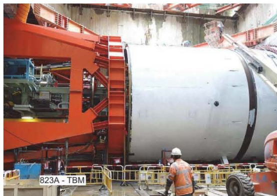
合約編號 823A 的隧道鑽挖機
