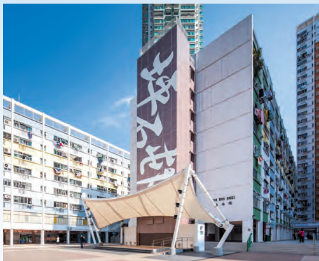
坪石邨新加建的升降機塔。
