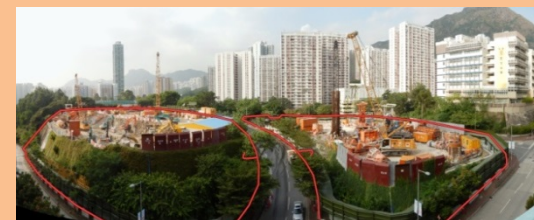
觀塘三彩區內的兩幅由「政府、機構或社區」改劃為住宅用地，作公共房屋發展。工程進行中。Two GIC sites in Sam Choi Area in Kwun Tong rezoned for public housing use. Work in progress.
