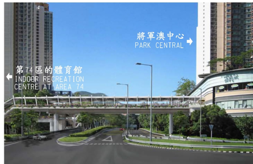
北面行人橋 NORTHERN FOOTBRIDGE
