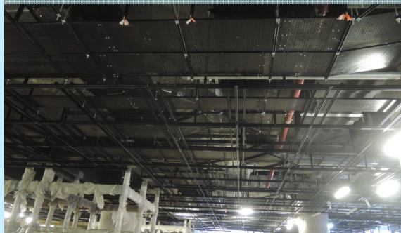
電線槽 Cable Containment
