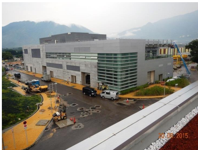
石崗列車停放處及緊急救援處的石崗大樓
