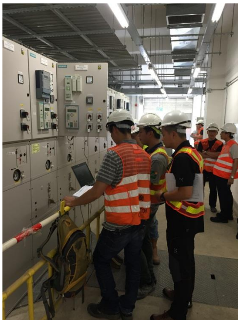
實地檢查位於石崗列車維修庫的 25,000 伏特高架電纜通電情況
