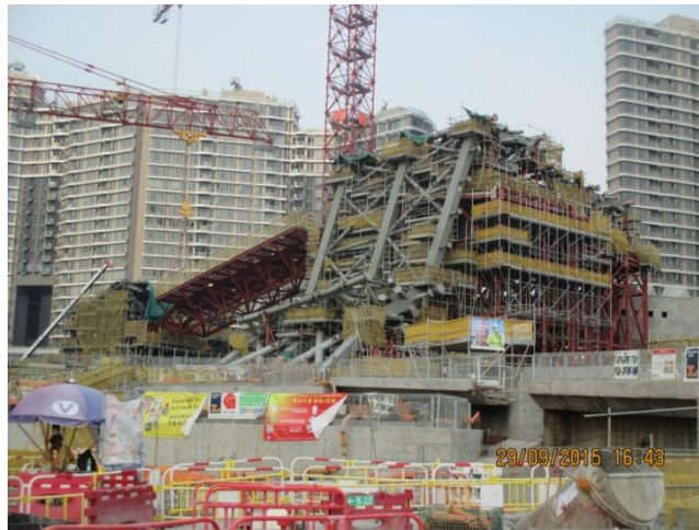
中央位置的永久支撐結構頂部鋼架
