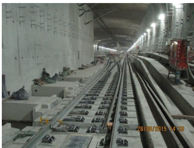
於隧道內進行安裝高架電纜及鋪設軌道工序
