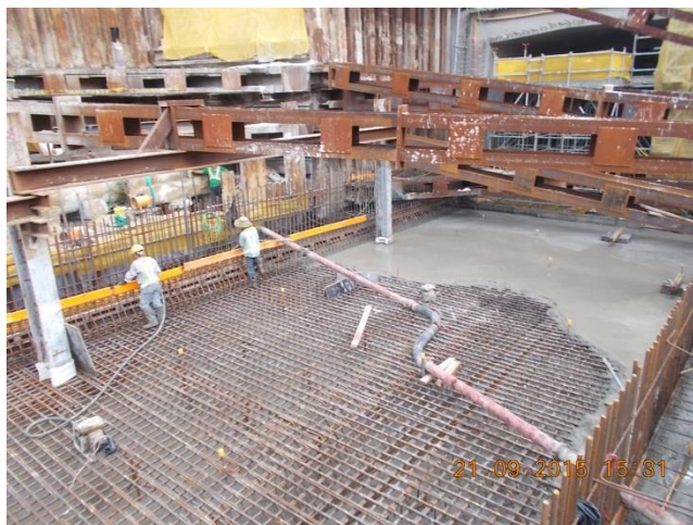
連翔道 / 柯士甸道西地下行車道的混凝土澆灌工程
