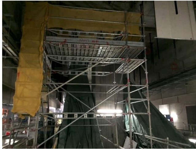
自動電梯正進行安裝工程
