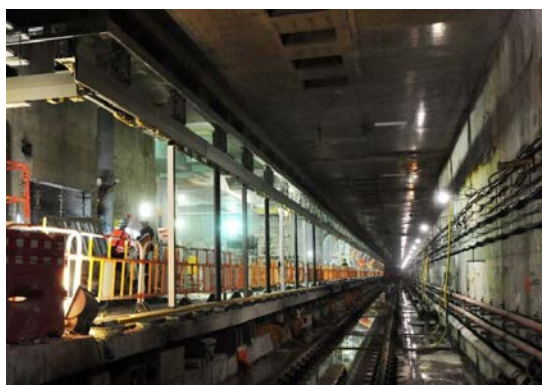
德安街地底現正進行架空電纜安裝工程
