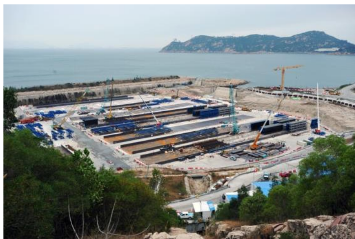
沉管隧道預製組件工場
