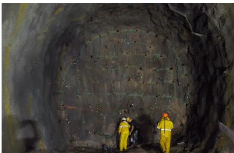
馬仔坑現正進行通風隧道挖掘工程
