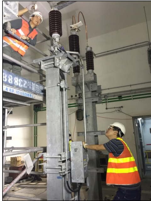
旺角西通風樓內所進行之饋電電纜連隔離開關電阻測試
