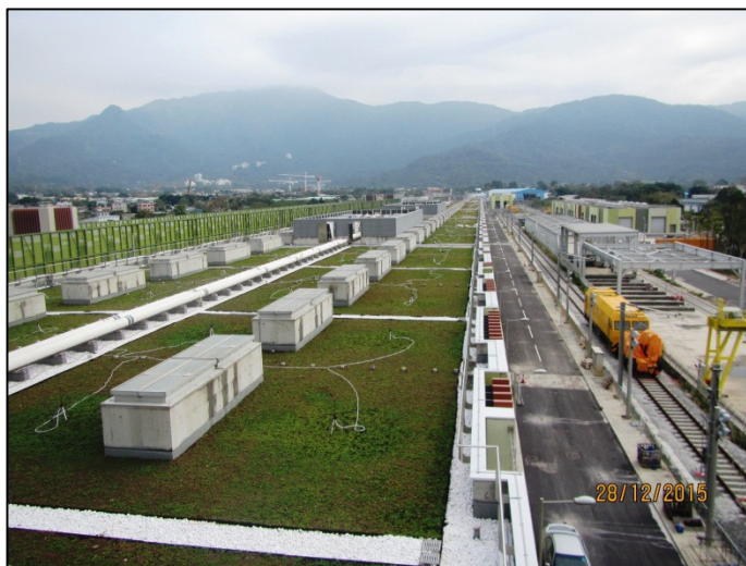
石崗列車停放處及緊急救援處內的列車維修庫頂蓋綠化
