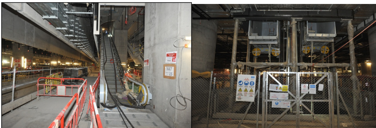
西九龍總站內的自動扶手電梯及升降機安裝工程
