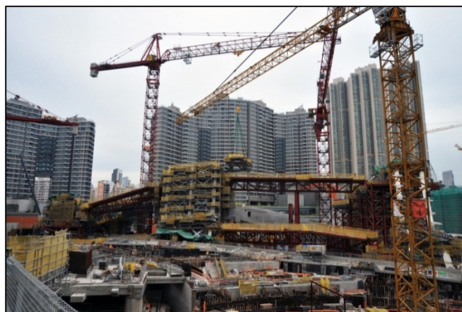
V 字型橫樑安裝工序正在西九龍總站工地進行
