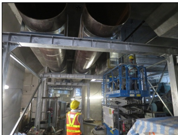
西九龍總站製冷機機房內安裝主冷凝水管
