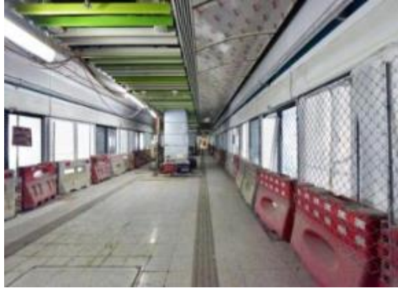
海怡半島站的裝修及機電工程進行中
