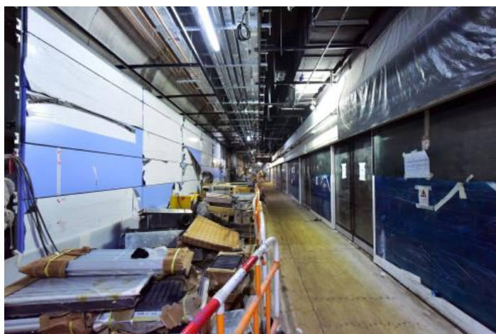
月台現正進行機電安裝工程
