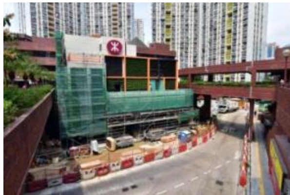
利東站 B 出入口的地面結構工程已完成
