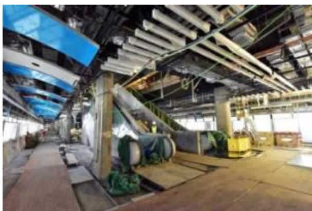
金鐘站的裝修及機電工程進行中
