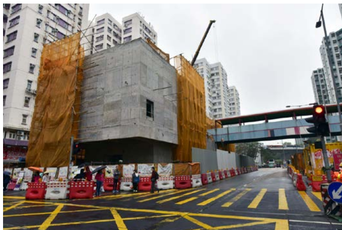
民兆街出入口現正進行外部裝修工程
