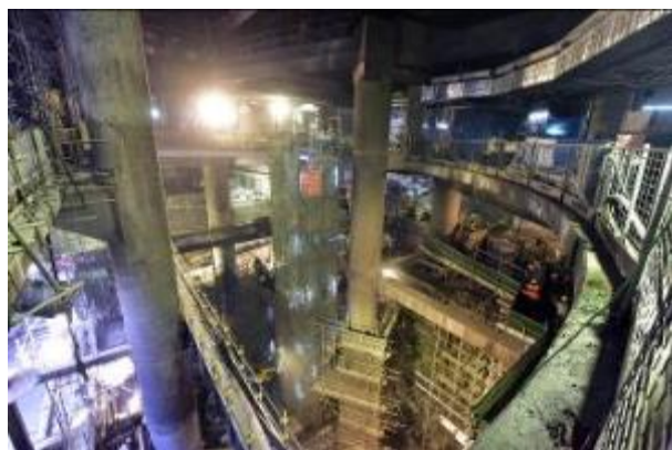
車站明挖回填挖掘工程大致完成
