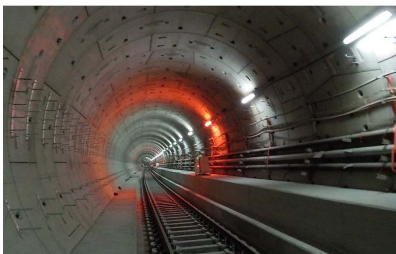
鑽石山上行綫隧道的路軌鋪設工程
