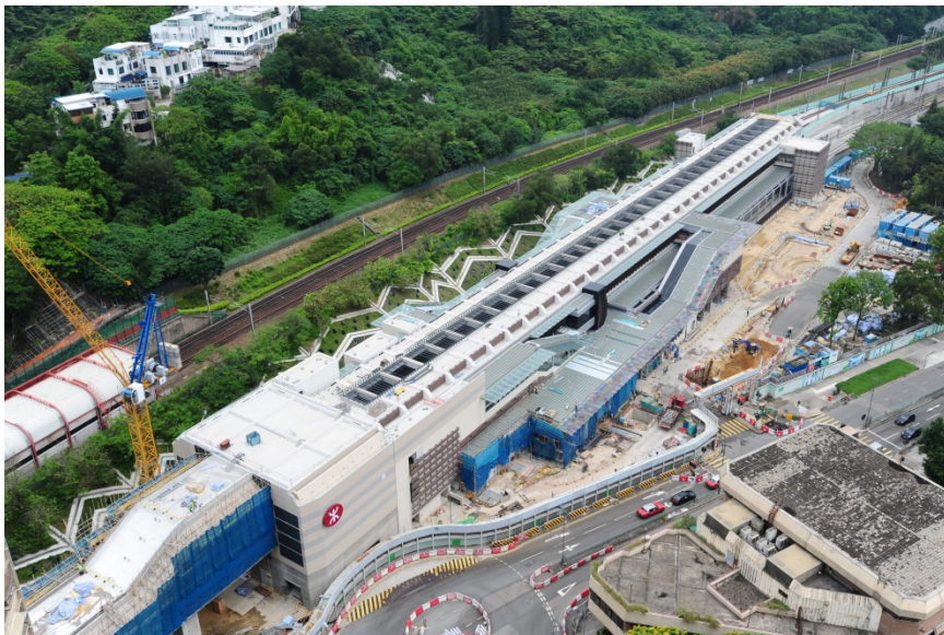
顯徑站及部分高架橋
