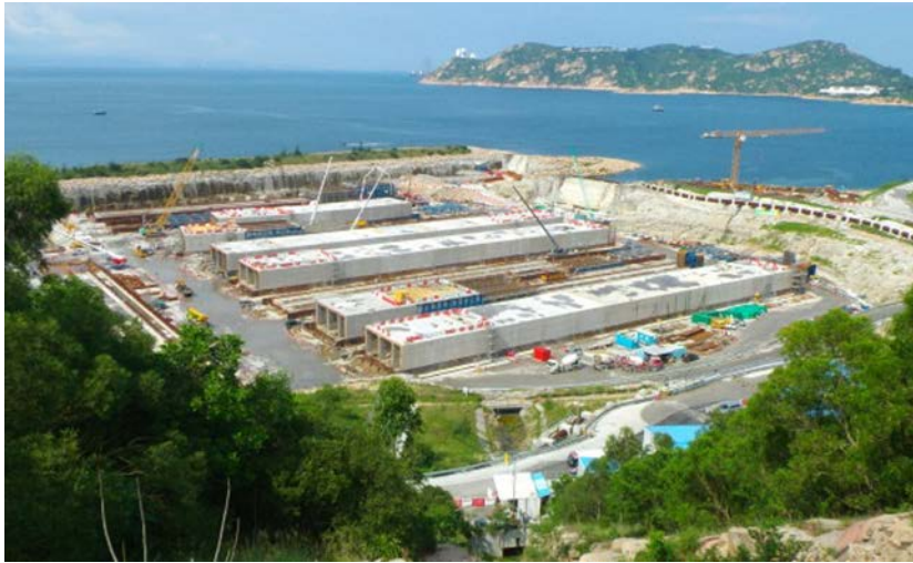
沉管隧道預製組件工場
