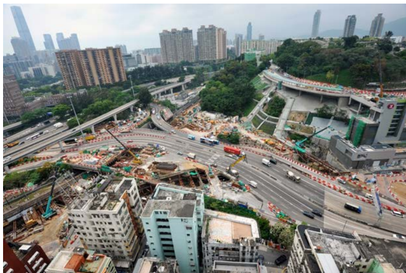
漆咸道北及溫思勞街旁的隧道挖掘工程
