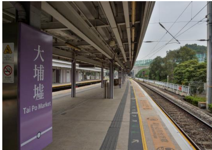
東鐵綫月台加固工程
