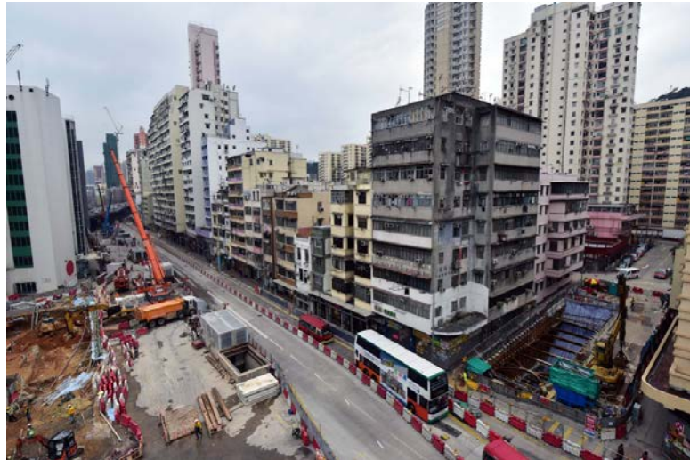
馬頭圍站工地
