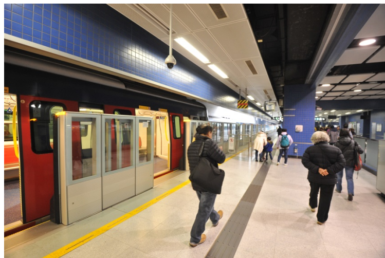
馬鞍山綫大圍站的自動月台閘門加裝工程已經完成
