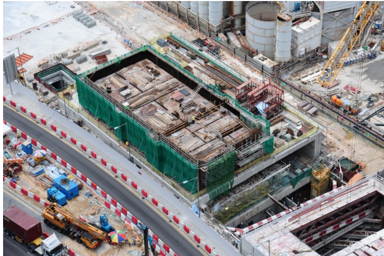
鑽石山站擴建工程
