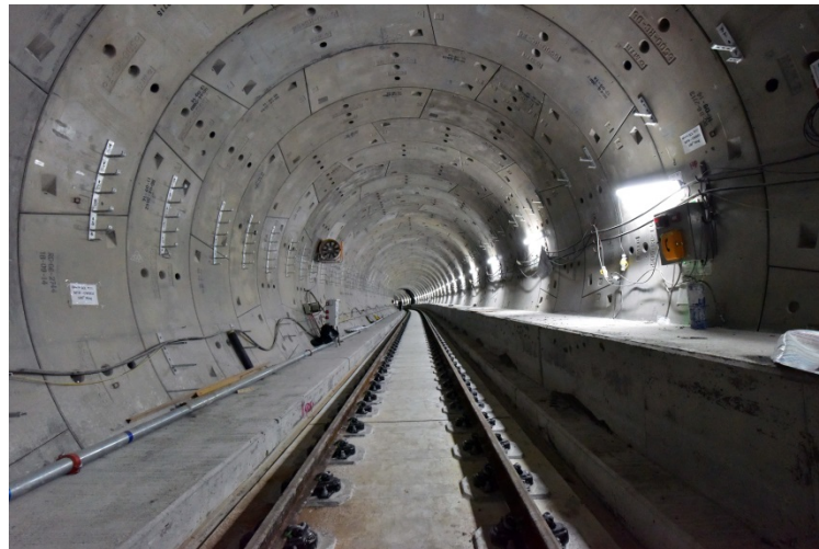
啟德至鑽石山下行綫隧道
