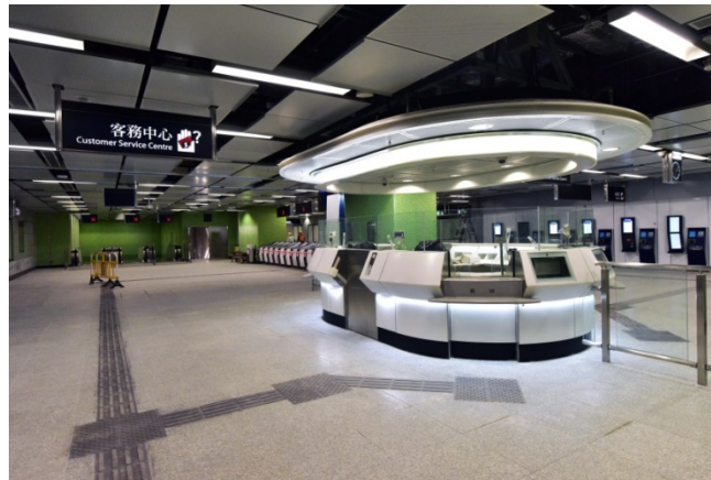
何文田站的車站設施已完成安裝
