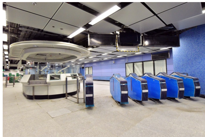
黃埔站東大堂的設備安裝工程已大致完成
