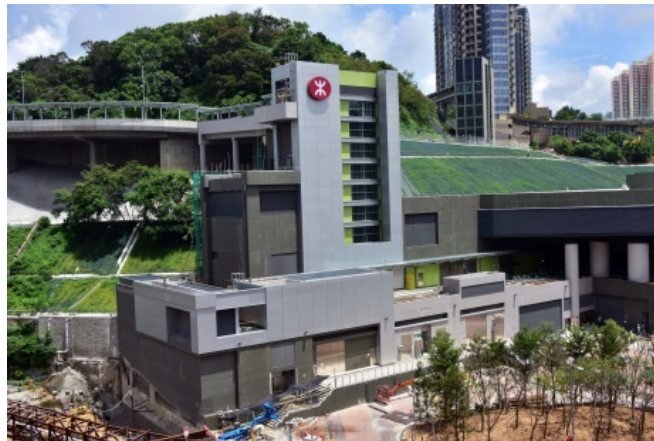
何文田站的外部裝修工程大致完成
