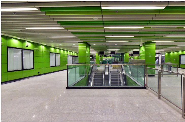
海怡半島站的裝修及機電工程接近完成
