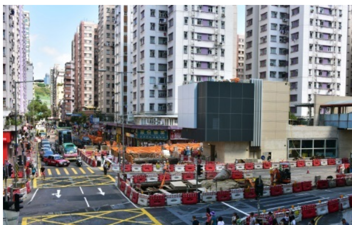
紅磡道現正進行路面重鋪工程
