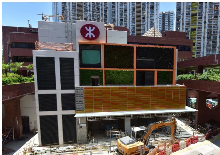
利東站結構工程已完成
