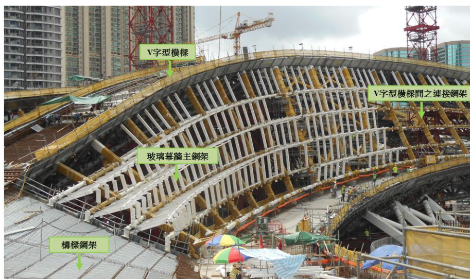
西九龍總站入口鋼結構西面的連接鋼架工程正在進行
