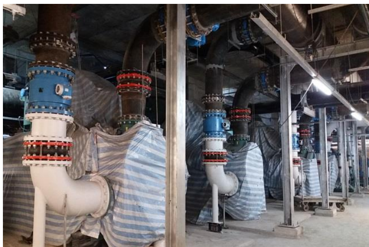
西九龍總站 B3 層的中央製冷機組已大致完成安裝
