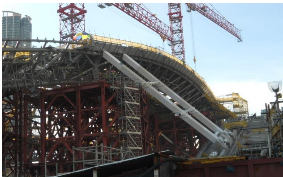
西九龍總站入口鋼結構東面將進行連接鋼架的裝嵌工程
