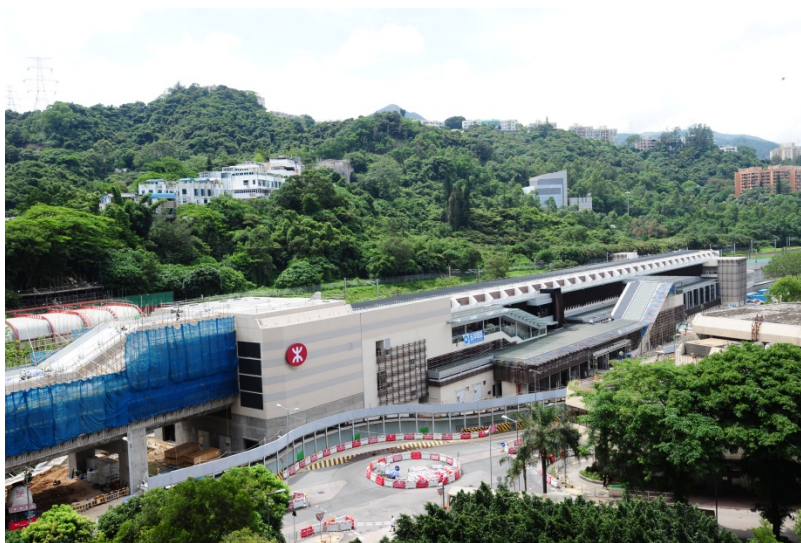
顯徑站及部分高架橋
