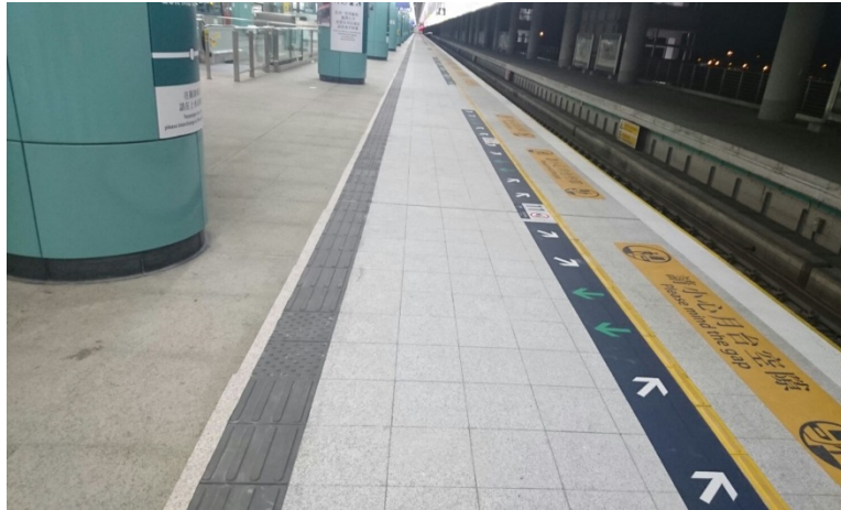
東鐵綫月台加固工程
