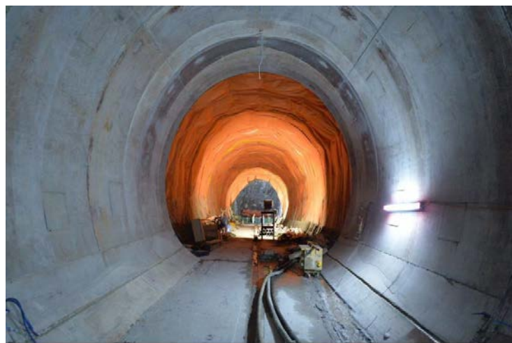
馬仔坑通風隧道的隧道壁工程
