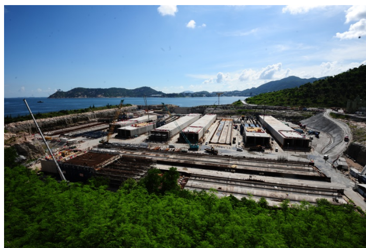
沉管隧道預製組件工場
