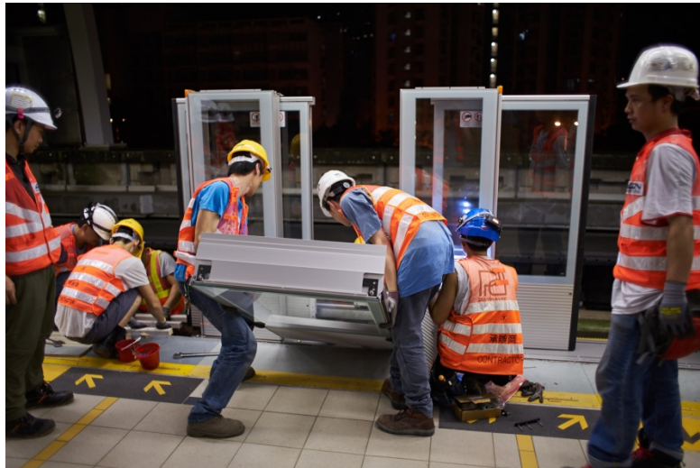
自動月台閘門加裝工程
