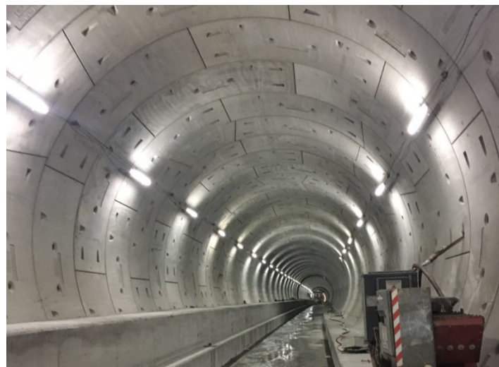
鑽石山至馬仔坑下行綫隧道的內部結構工程
