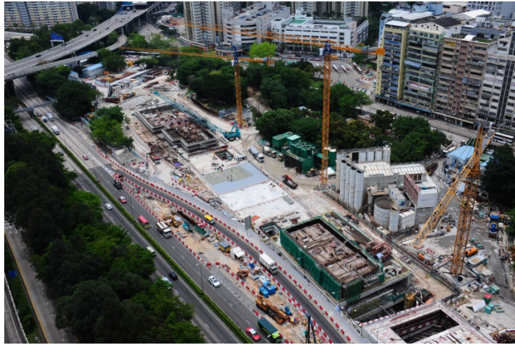
鑽石山站擴建工程
