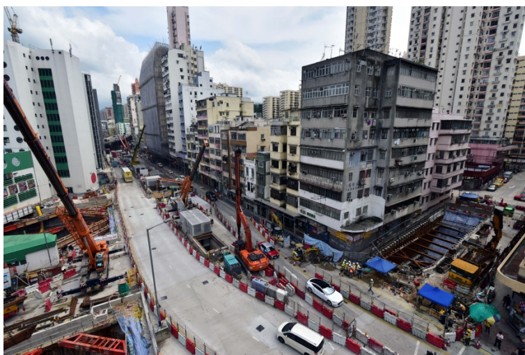
馬頭圍站工地
