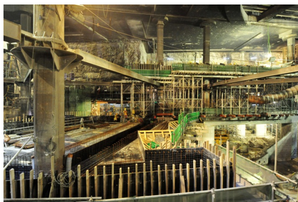
金鐘站港島綫隧道支撐架工程
