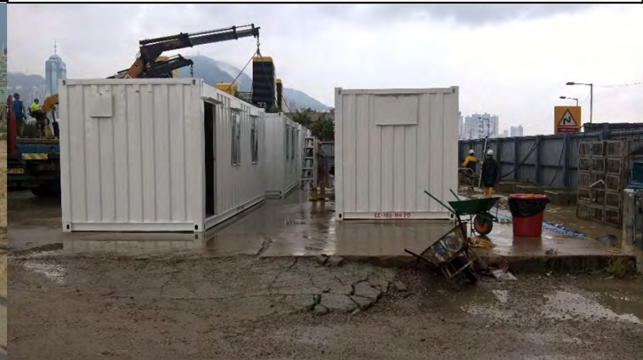
Site office set up 設置工地辦公室
