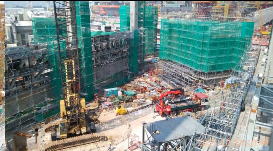
Mega Trusses assembled 主要支架組裝
