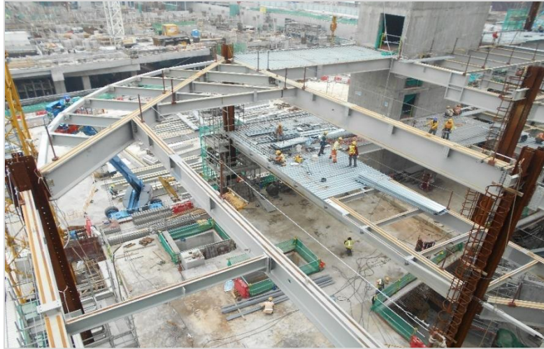
Perimeter Steelwork (North & East) and Slab Construction 外圍主要鋼結構支架(北部和東部)及樓 板安裝
