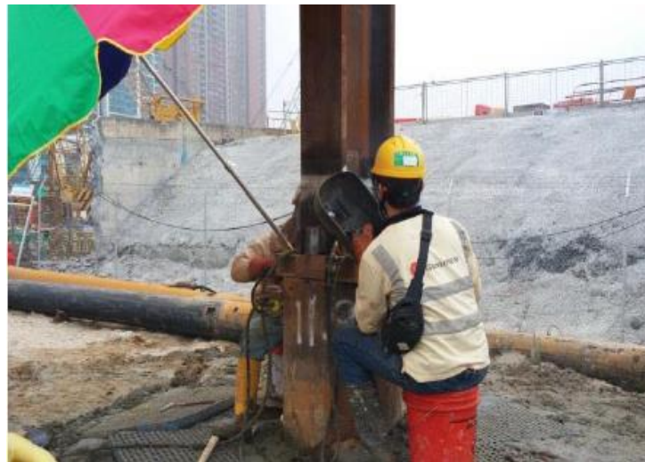
H-Pile Splice Jointing 焊接工作
