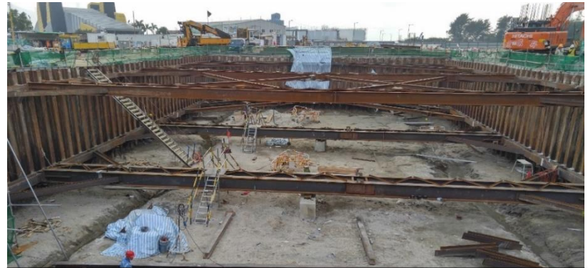
ELS Works at District Cooling System 區域供冷系統挖掘工程側向支撐工作
