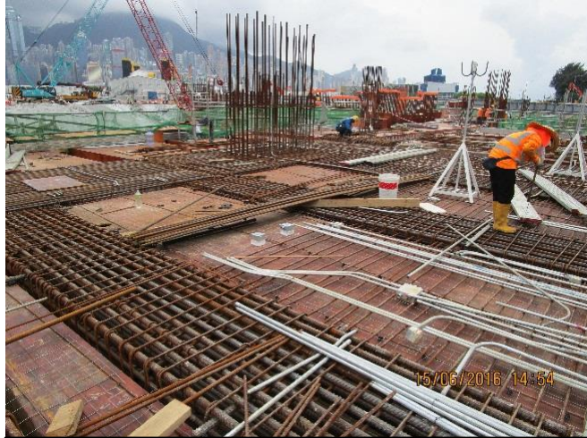
Conduit Installation at Basement Level 1 Slab 安裝燈喉在第一層地庫地台
