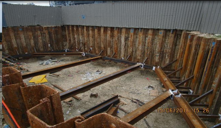
Partial ELS Works for Sewage Pumping Station Area 污水泵房區部分挖掘及側向支撐安裝工程
