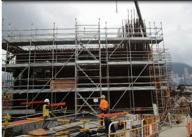
Basement Level 1 East Core Wall Construction 第一層地庫東面主牆建築中
