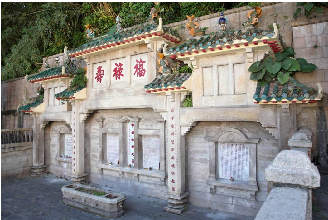
傳統的四坡頂蓋上綠色琉璃瓦，上有陶塑裝飾。 正中的主牌樓刻有福、祿、壽三字。
