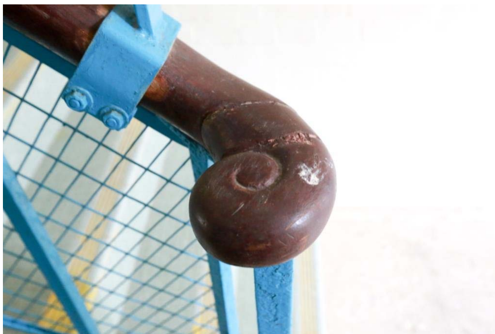
室內樓梯的卷形扶手端。
