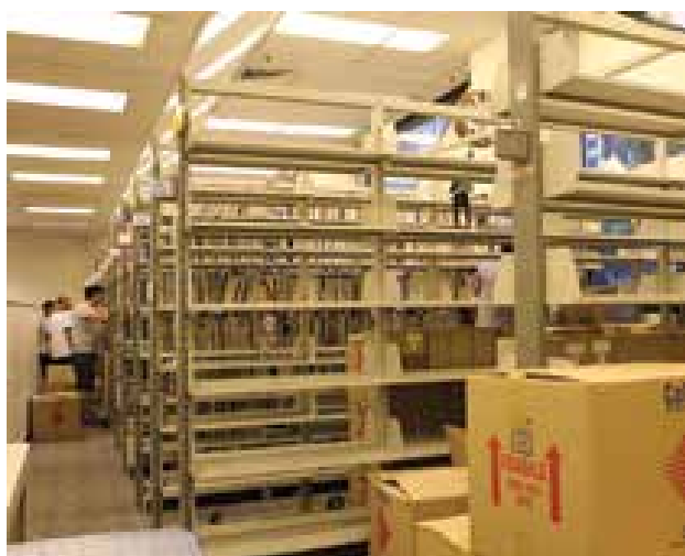
The renovation of the Academy Library. 學院圖書館的整建工程。
