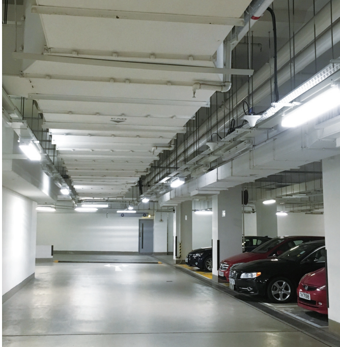
生物資訊中心停車場的螢光燈已更換為內置有活動／光電傳感器的LED燈，有效節省能源
