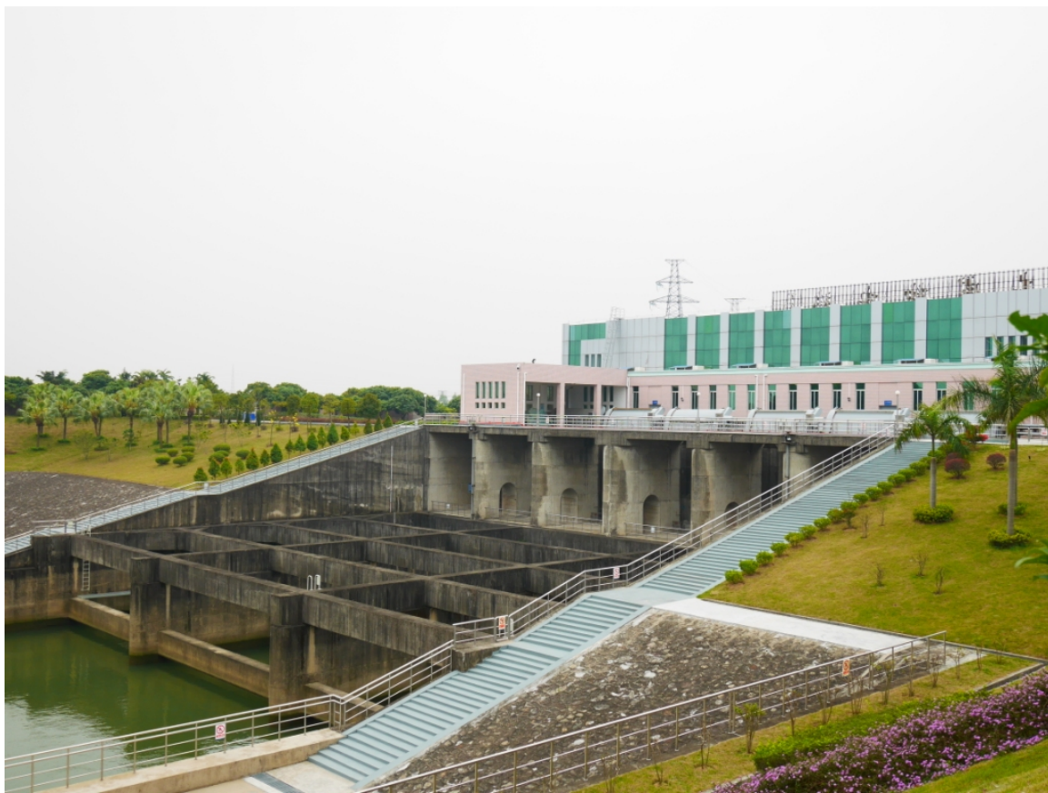
東莞市太園泵站
