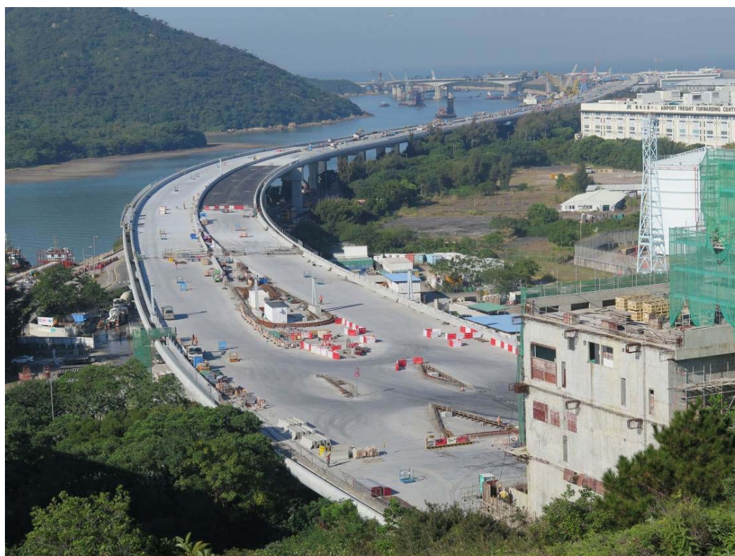
圖十：香港接線陸上高架橋已完成橋面結構安裝，現正進行橋面鋪裝工程
