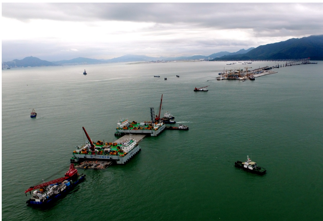
圖三：大橋主橋島隧工程沉管隧道管節安裝
