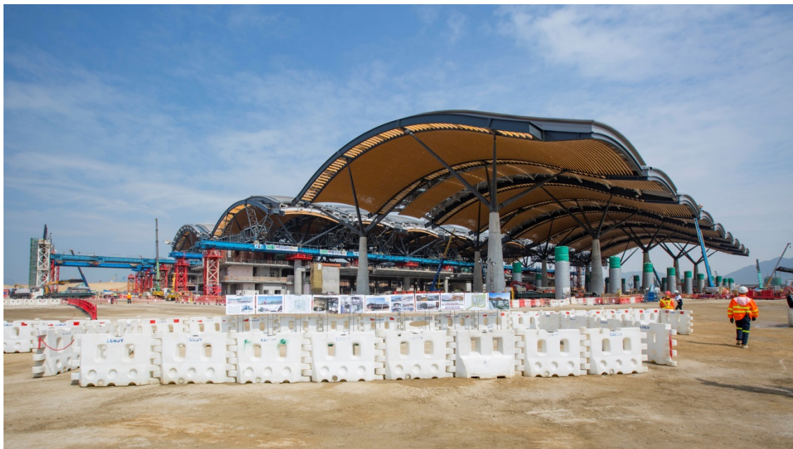
圖五：香港口岸旅檢大樓的屋頂預製組件正在安裝
