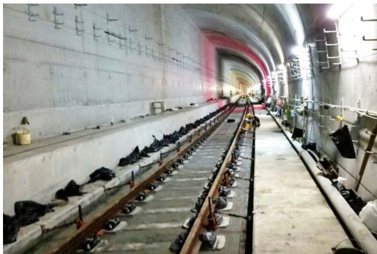
鑽石山至馬仔坑隧道的路軌工程
