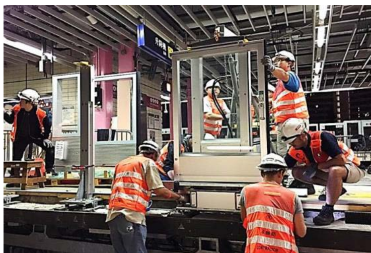
自動月台閘門加裝工程
