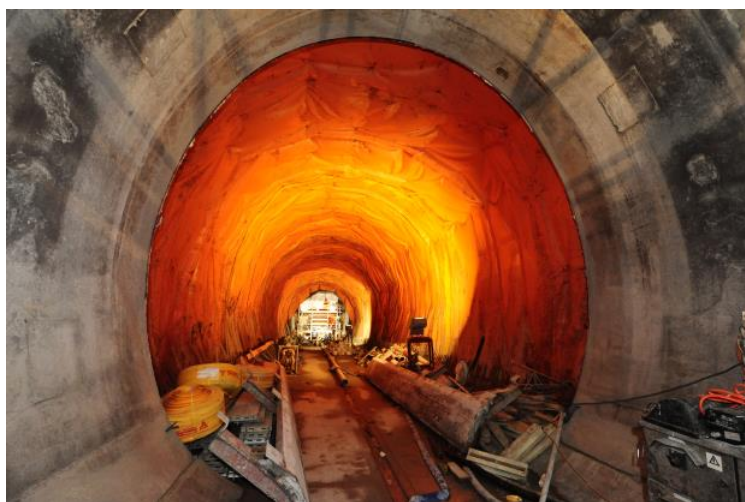
馬仔坑通風隧道的隧道壁工程
