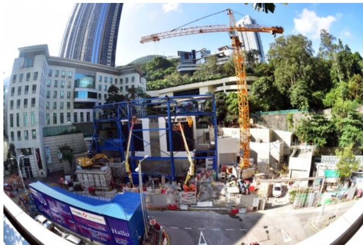
沙中綫越位隧道香港公園工地
