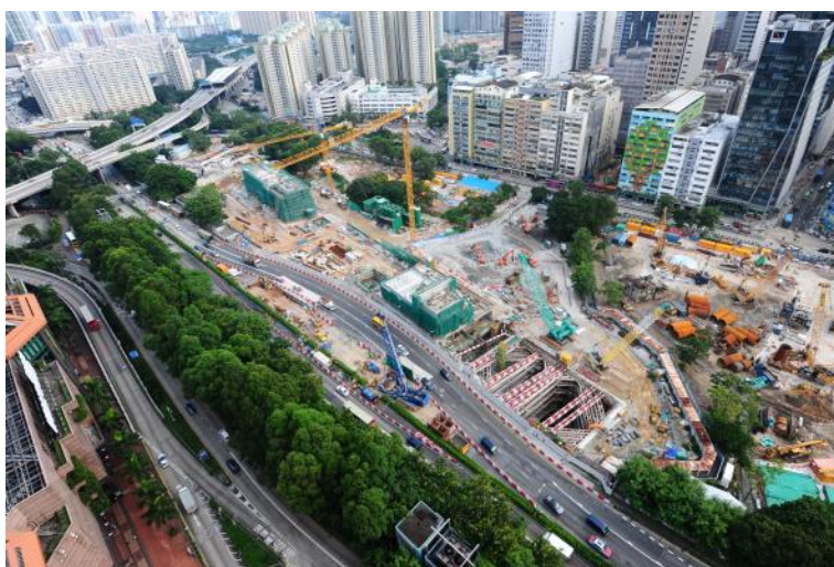
鑽石山站擴建工程
