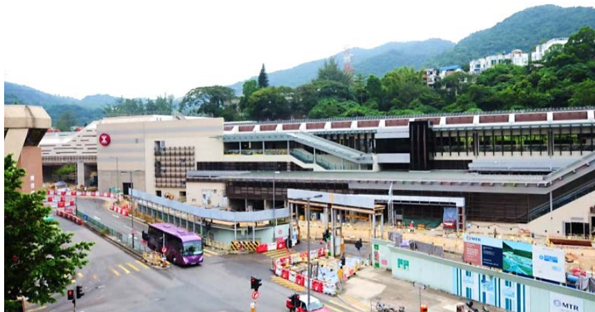
顯徑站及部分高架橋
