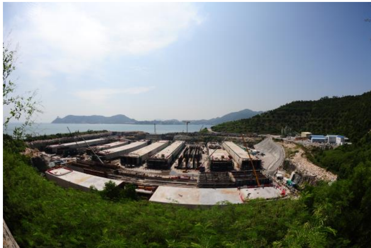
沉管隧道預製組件工場
