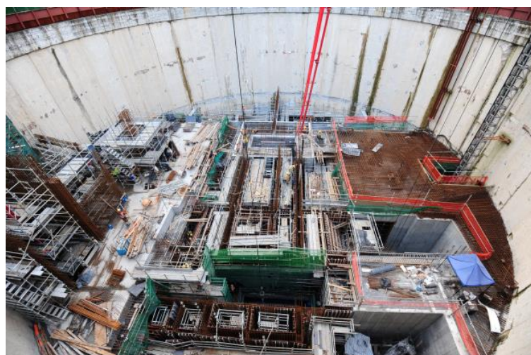
馬仔坑通風豎井結構工程
