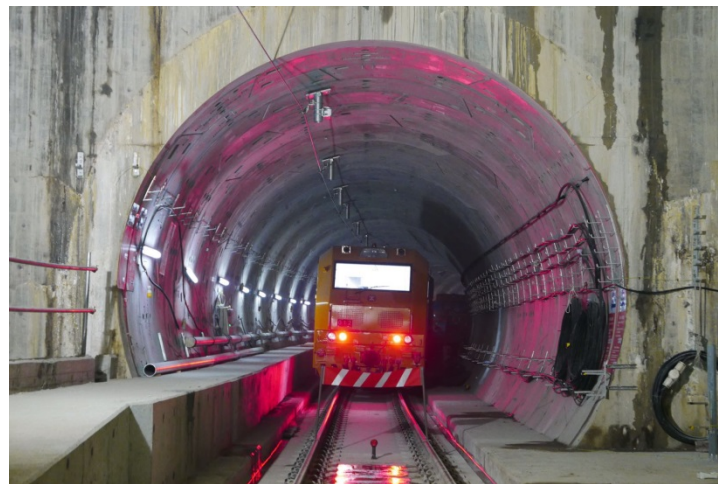
啟德至鑽石山隧道正進行軌道設備安裝工程
