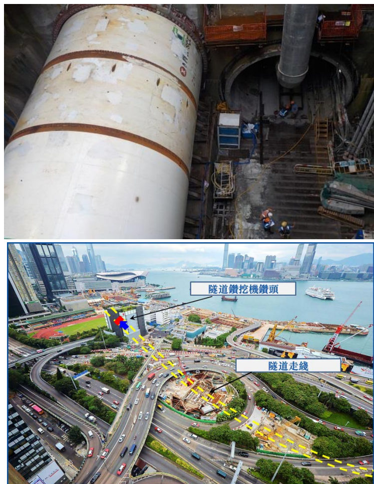
銅鑼灣避風塘至會展站的下行綫隧道的鑽挖工作已經完成
