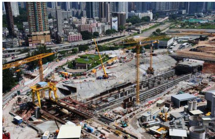
土瓜灣站結構工程
