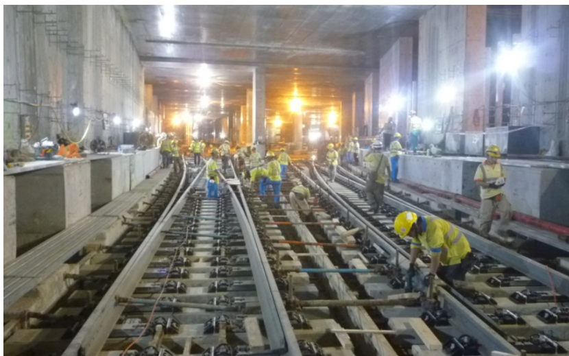
西九龍總站連接隧道南段正進行軌道及道岔鋪設工序
