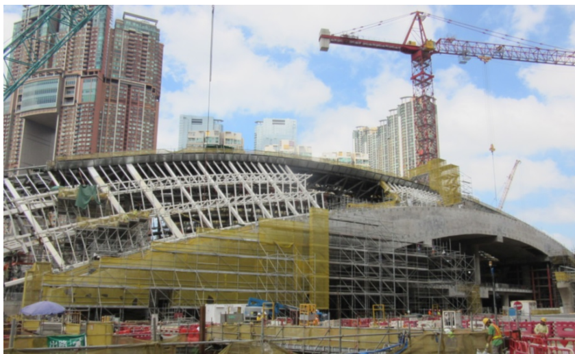
西九龍總站入口鋼結構東面的連接鋼架裝嵌工程
