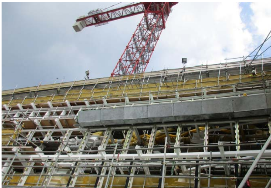
西九龍總站入口鋼結構西面的玻璃組件及鋁製組件 底框安裝工程
