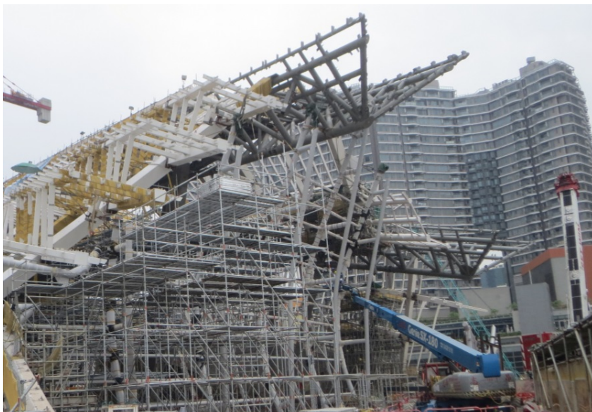
西九龍總站入口鋼結構南面的幕牆
