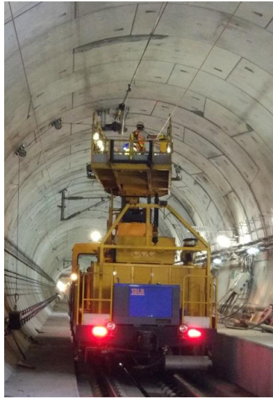
隧道內進行架空電纜穿線工程
