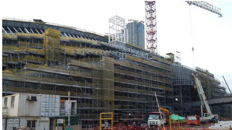
西九龍總站入口鋼結構東面的升降機及連接鋼架裝嵌工程
