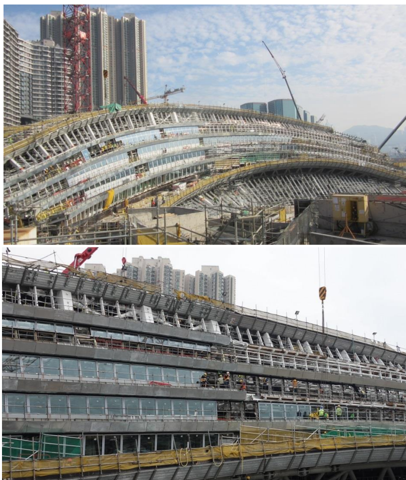
西九龍總站入口鋼結構西面的玻璃組件安裝工程
