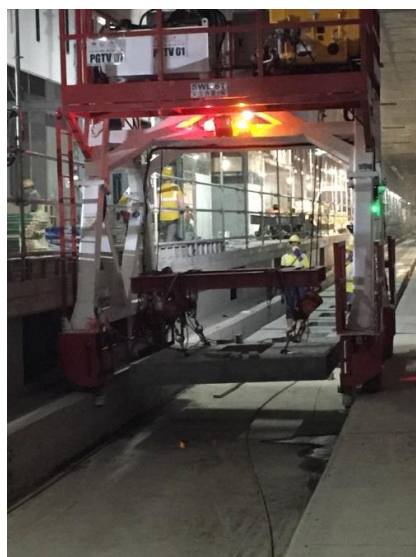
以特製吊運龍門架於西九龍總站北 月台層鋪設軌床混凝土預製組件
