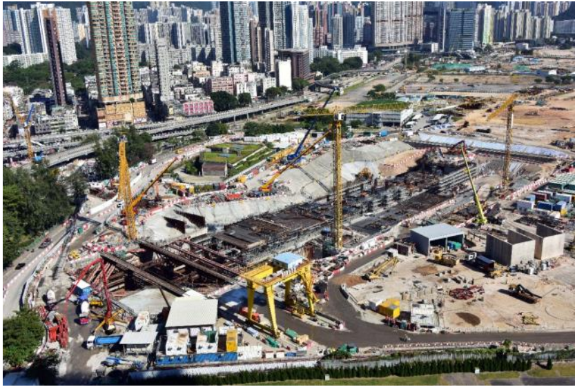
土瓜灣站結構工程
