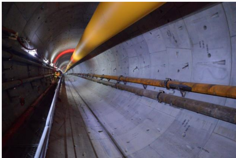
銅鑼灣避風塘至會展站的上下行綫隧道的鑽挖工作已經完成
