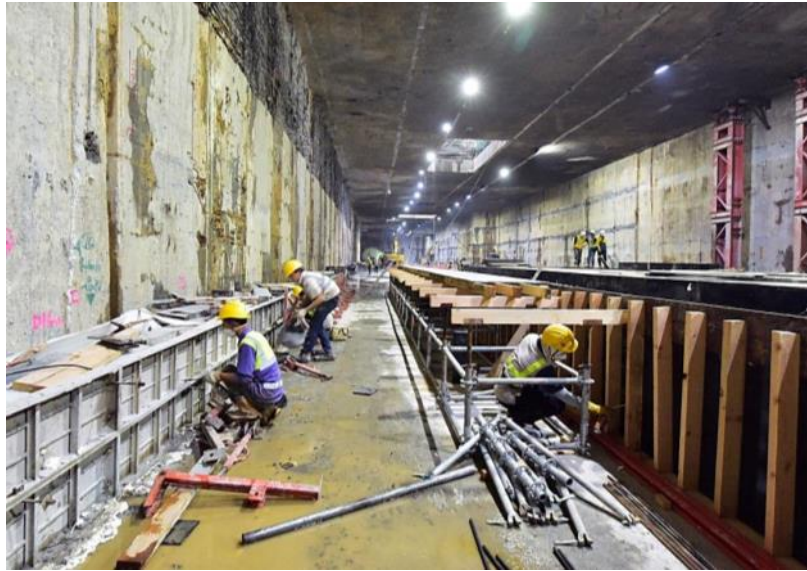
馬頭圍站建造工程
