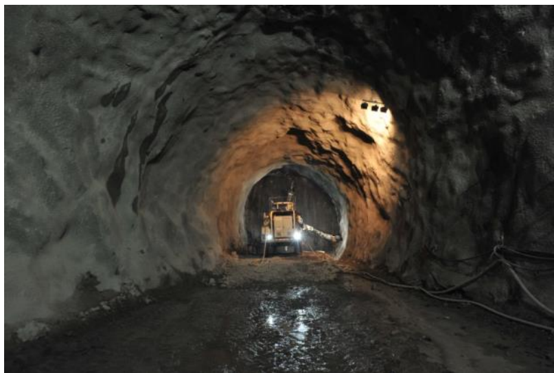
沙中綫越位隧道正進行鑽爆工程
