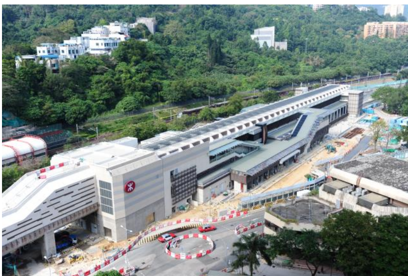
顯徑站及部分高架橋
