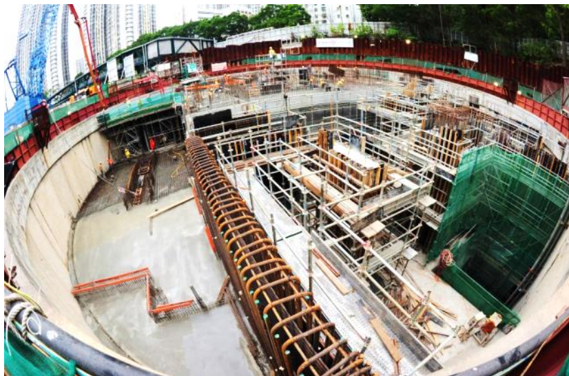
馬仔坑通風樓結構工程
