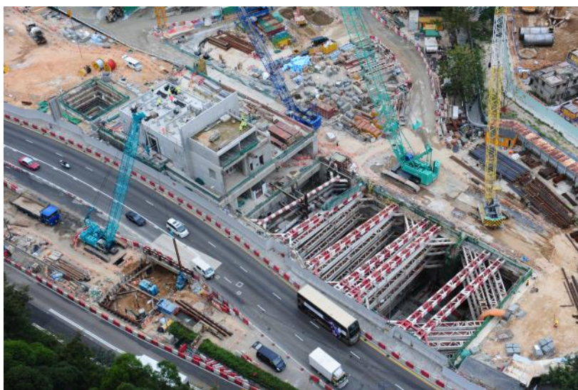
鑽石山站擴建工程
