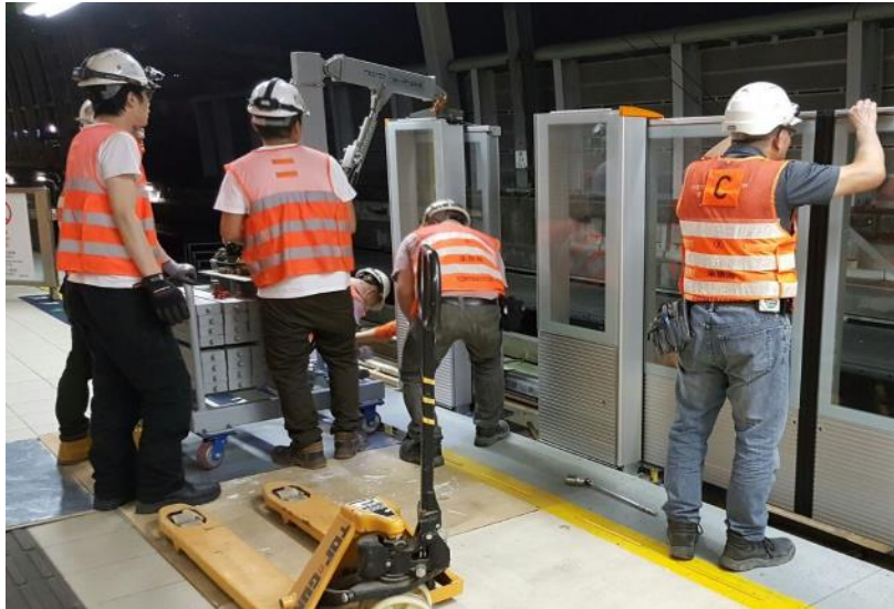
自動月台閘門加裝工程
