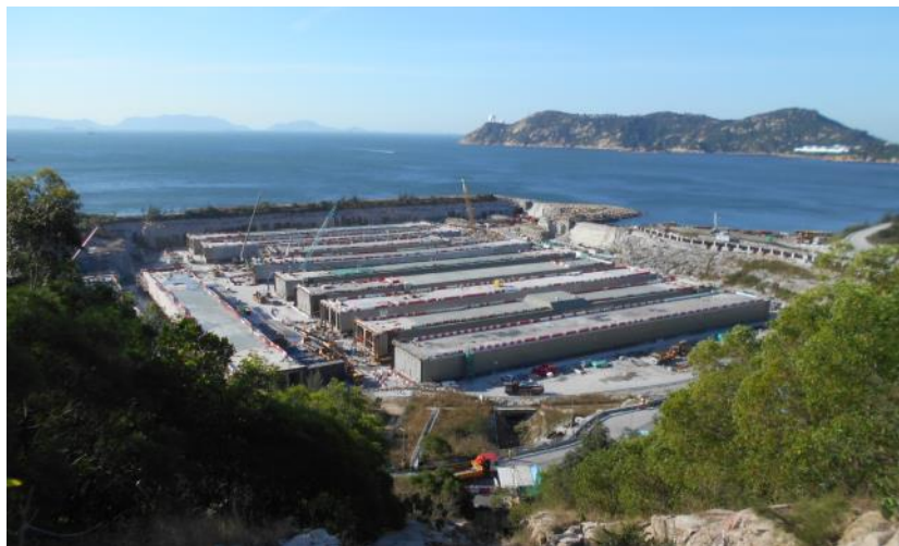
沉管隧道預製組件的結構已大致完成
