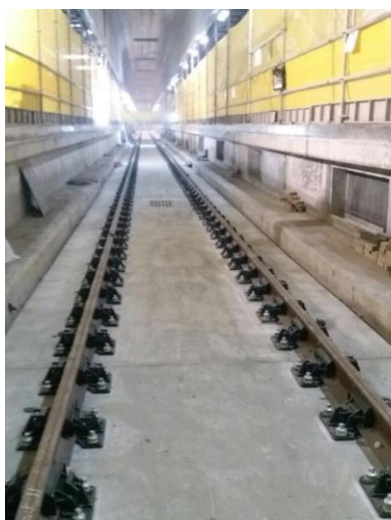
西九龍總站月台層的軌道鋪設工程已完成
