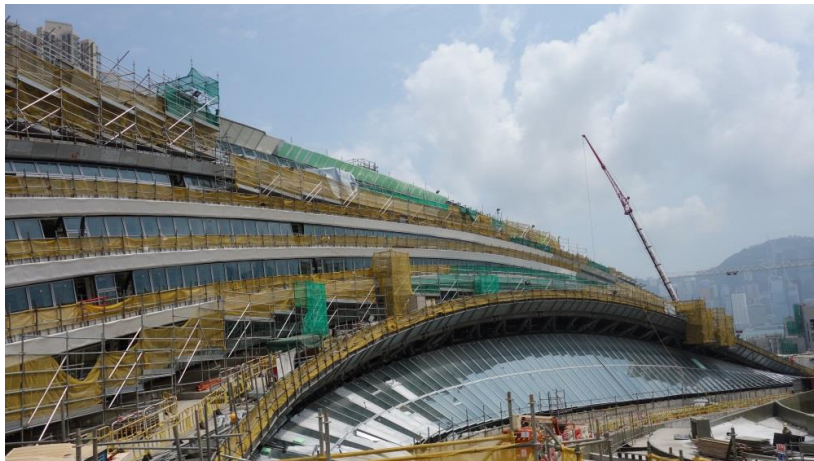
西九龍總站入口鋼結構西面的玻璃組件安裝工程
