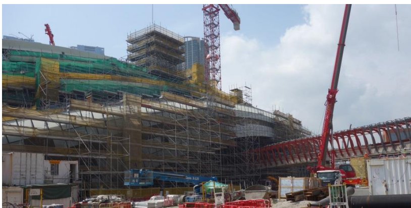
西九龍總站入口鋼結構東面的幕牆安裝工程
