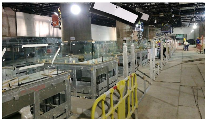
於西九龍總站 B3 層香港海關、出入境及檢疫設施位置正在安裝出入境櫃位
