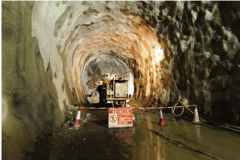
沙中綫越位隧道正進行鑽爆工程
