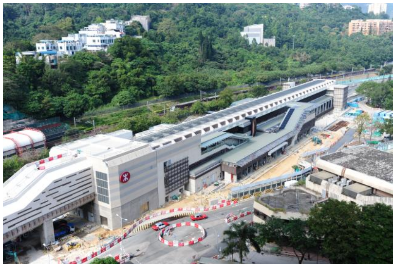
顯徑站及部分高架橋
