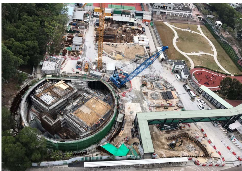
馬仔坑通風樓結構工程
