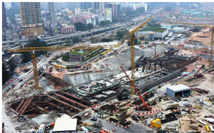
土瓜灣站結構工程
