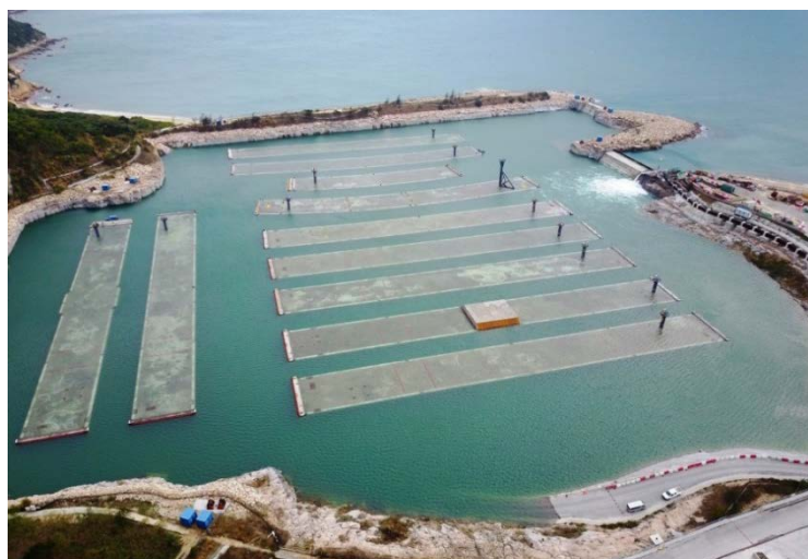
沉管隧道預製組件工場已重新注入海水， 準備將預製組件逐一浮起及運出維港沉放
