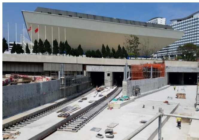
在紅磡列車停放處進行的路軌鋪設工程
