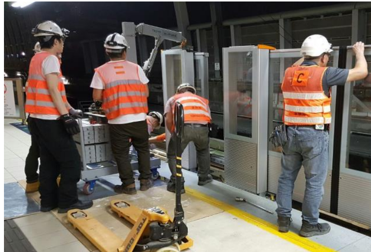
自動月台閘門加裝工程
