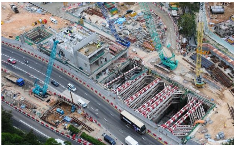
鑽石山站擴建工程
