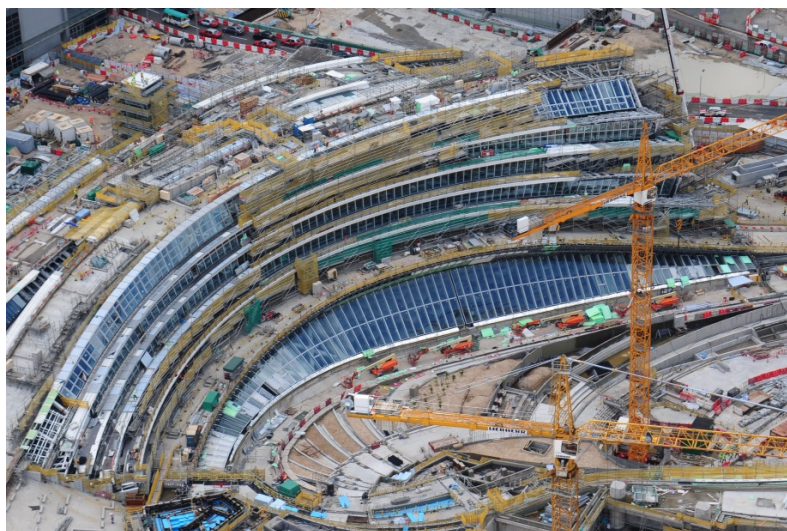
西九龍站入口西面的玻璃組件安裝工程
