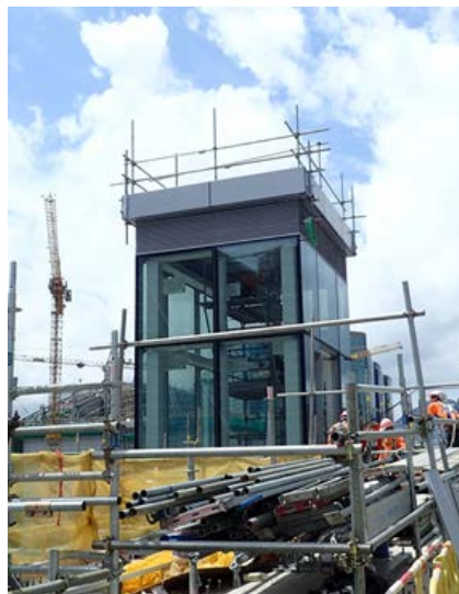
西九龍站入口東面站頂的升降機安裝工程
