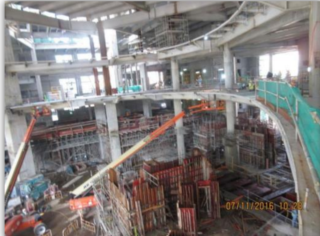
Snapshot at low zone (below 4/F) 低層地區(四樓以下)簡況
