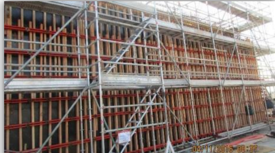
Formworks for Core Wall at B1 Slab Level 在地庫一層位置安裝隔水牆模板
