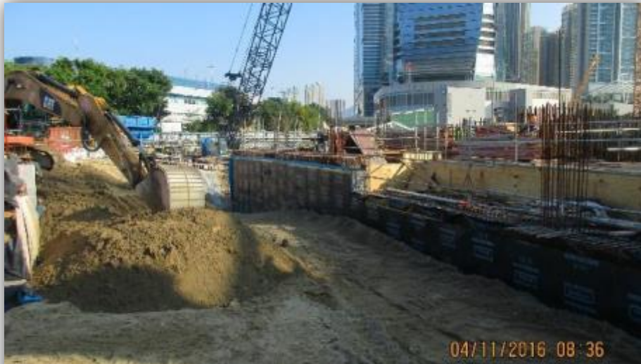
Backfilling at B1 Slab 地庫一層位置充填
