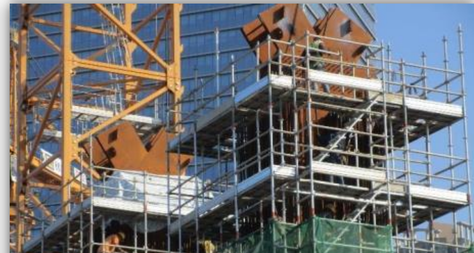
Construction of Composite Column 混合式的柱子
