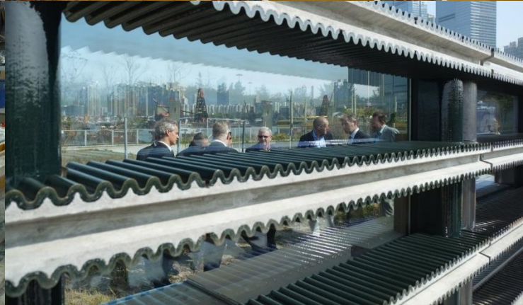
M+ Façade Ceramic Mock-ups M+ 陶瓷製的建築物外牆樣板
