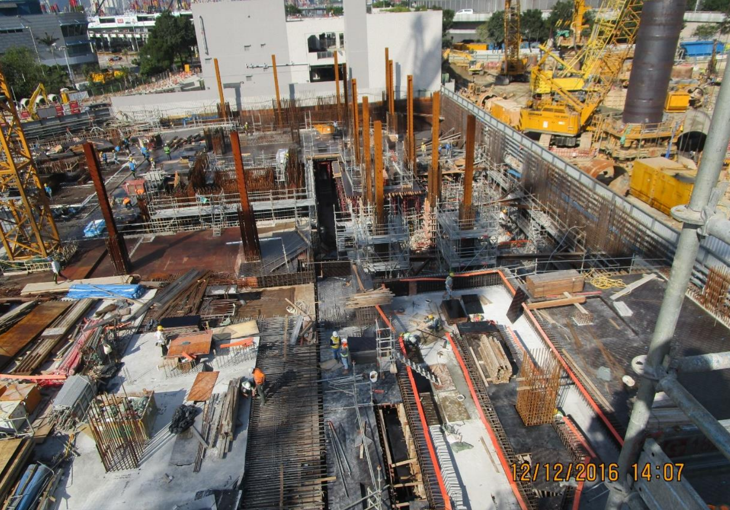
Core Wall and Columns of RDE/OACF Building 零售/餐飲/消閒及其他文化藝術設施大樓的主力牆及柱體
