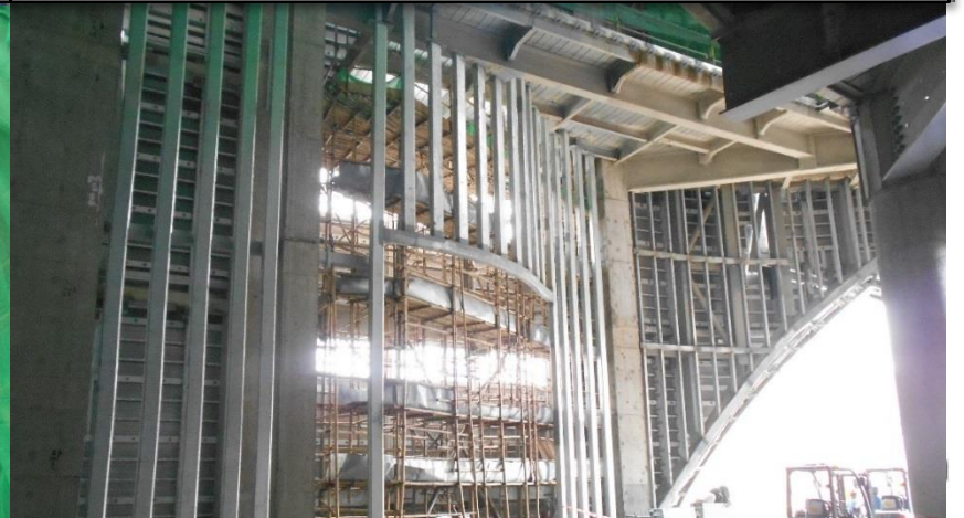
Sub-frame installation ( G/ F ) 安裝地面副綱架
