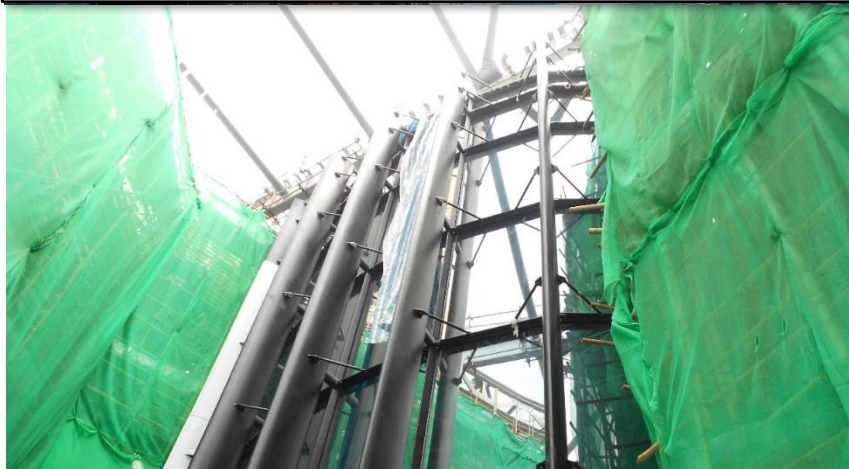
Cladding glass wall ( 4/F ) 四樓的電鍍玻璃牆
