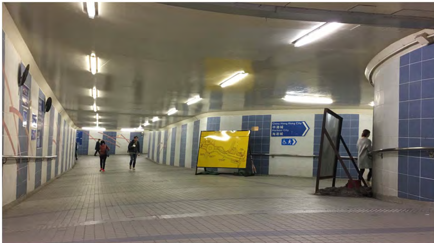
柯士甸道行人隧道內 - 現時狀況
