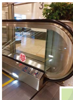
扶手電梯的緊急按鈕附近貼上新設計的「緊急停掣」標貼
