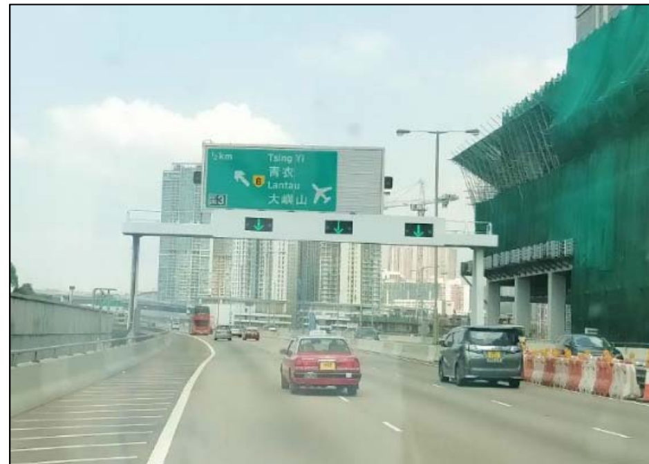
Existing Directional Sign 現時的路線指示標誌:
