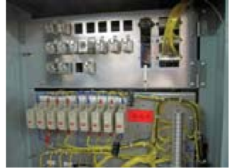
在控制櫃內裝設障礙開關掣
