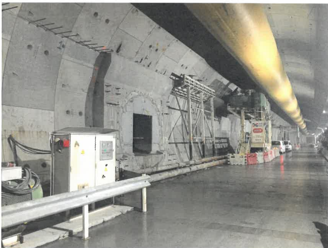
相片二— 永久防水工程已完成（連接通道 17 號）（拍攝日期：2017 年 10 月 19 日）
