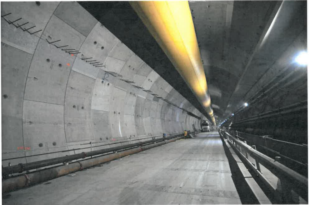
相片三 — 隧道主管道的結構狀況（拍攝日期：2017 年 9 月 30 日）
