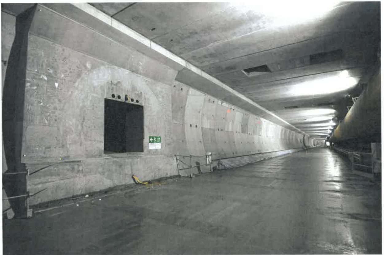
相片四 — 隧道主管道及連接通道的結構狀況（拍攝日期：2017 年 9 月 30 日）
