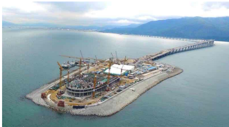
2017年5月 东人工岛扭工字块安装完成
