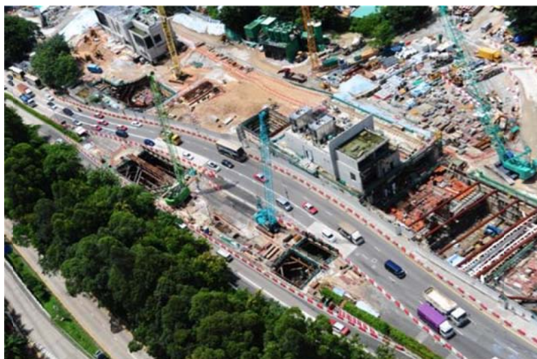
鑽石山站擴建工程
