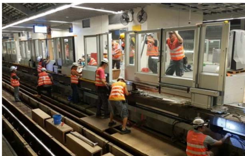
自動月台閘門加裝工程
