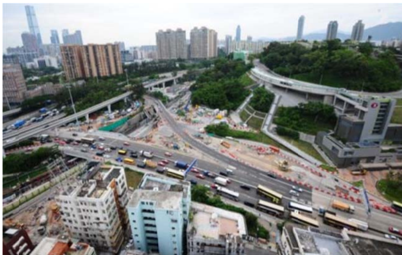
漆咸道北近溫思勞街旁的結構工程
