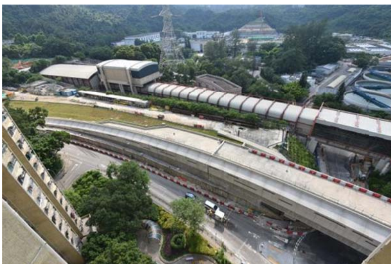
顯徑站及部分高架橋
