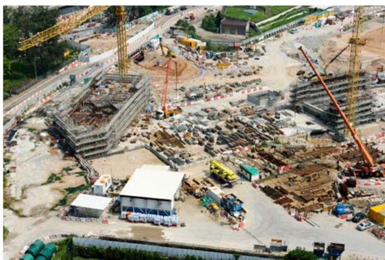
土瓜灣站結構工程
