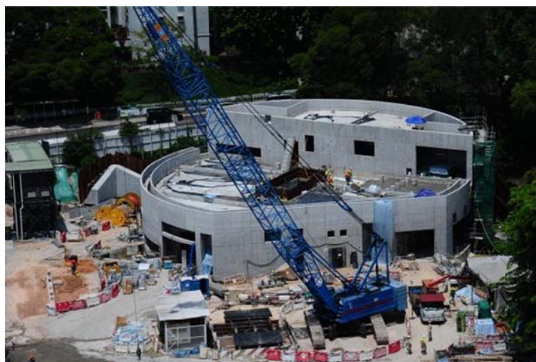
馬仔坑通風樓結構工程
