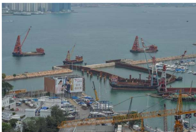
首件沉管隧道預製組件已成功安裝於維港海床(圖為沉放中的預製組件)
