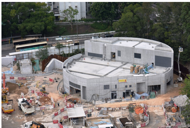
馬仔坑通風樓結構工程
