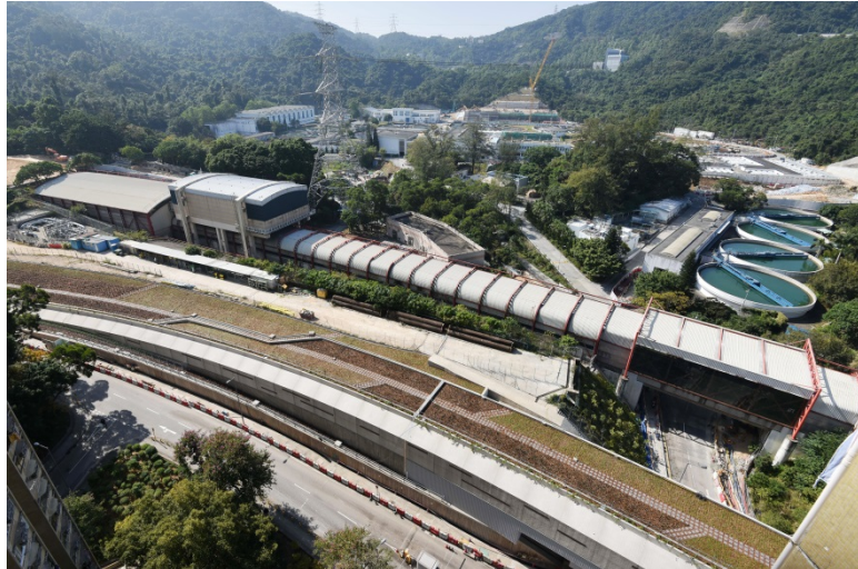
顯徑站及部分高架橋
