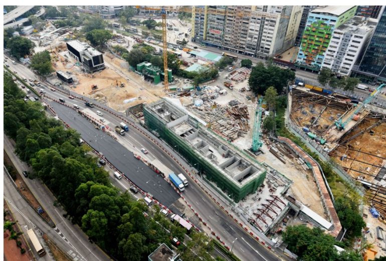
鑽石山站擴建工程
