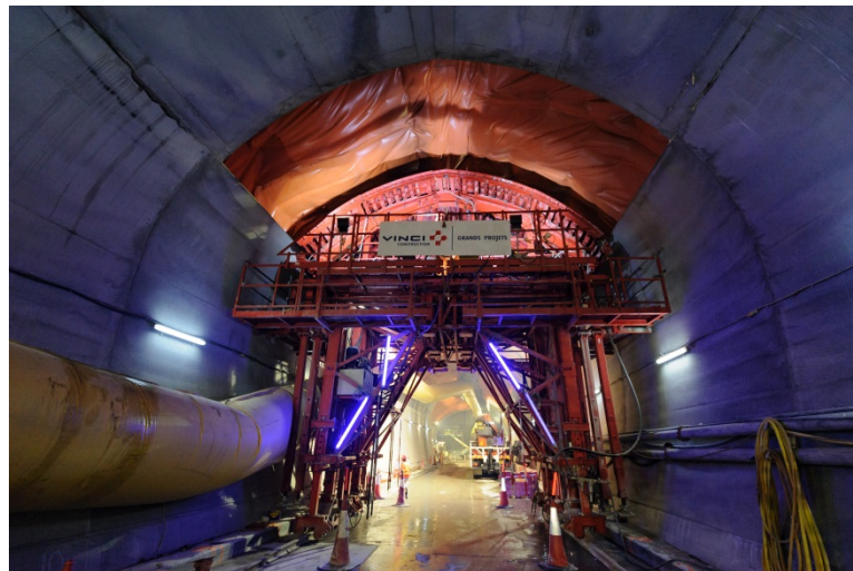
越位隧道正進行結構工程
