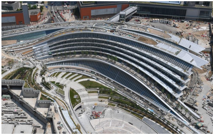
香港西九龍站的建造工程已大致完成
