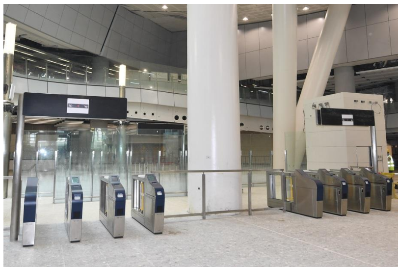
香港西九龍站內的閘機已完成安裝
