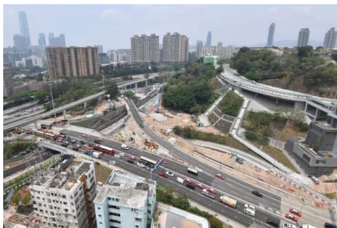
漆咸道北、溫思勞街行車隧道連接路及康莊道連接路的臨時交通管理措施已經完成
