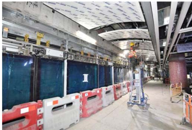
紅磡站正安裝機電設備
