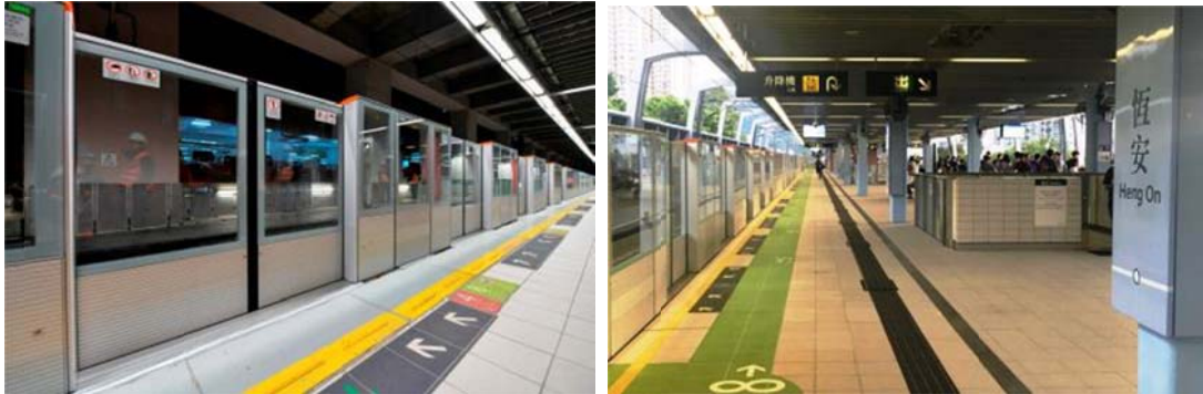
馬鞍山綫車站自動月台閘門加裝工程全面完成
