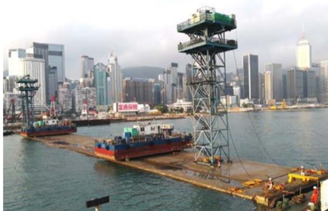
已於維港海床成功安裝全部十一件沉管隧道預製組件
