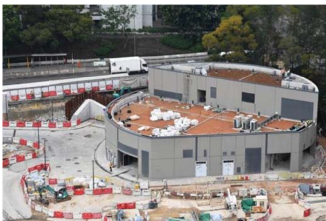
馬仔坑通風樓結構工程
