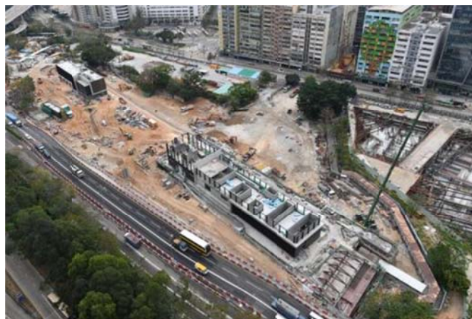
鑽石山站擴建工程
