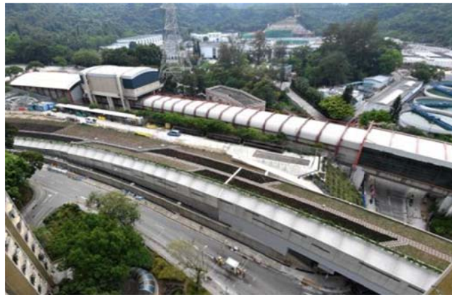
顯徑站及部分高架橋
