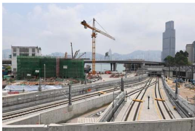
紅磡列車停放處架空電纜安裝工程大致完成
