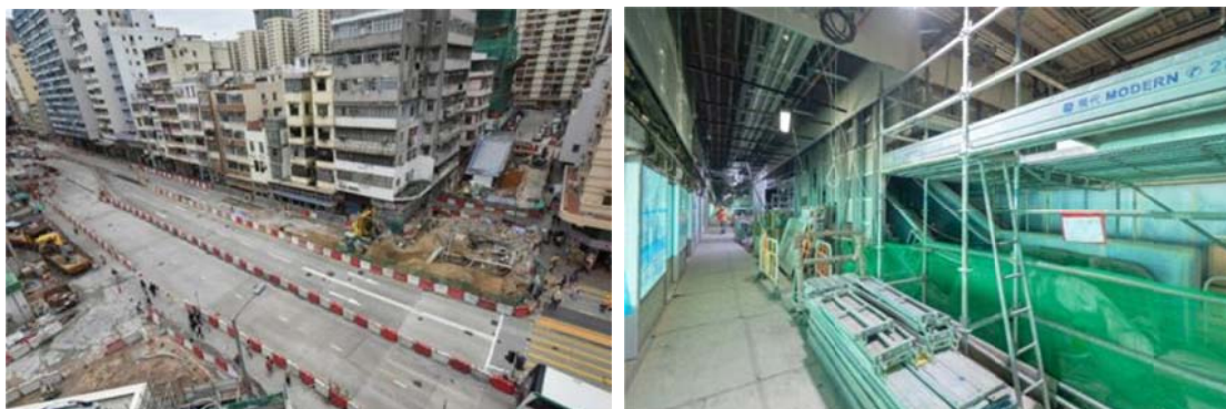
土瓜灣站建造工程
