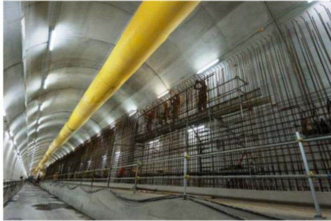
越位隧道的隧道壁工程
