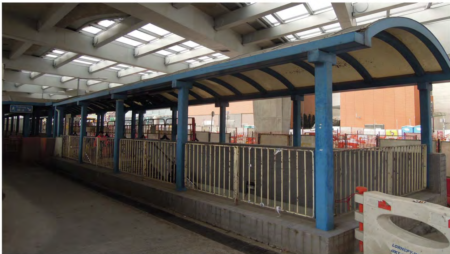
柯士甸道行人隧道戲曲中心入口 - 現時狀況 AUSTIN ROAD PEDESTRIAN SUBWAY ENTRANCE AT XIQU CENTRE - EXISTING CONDITION
