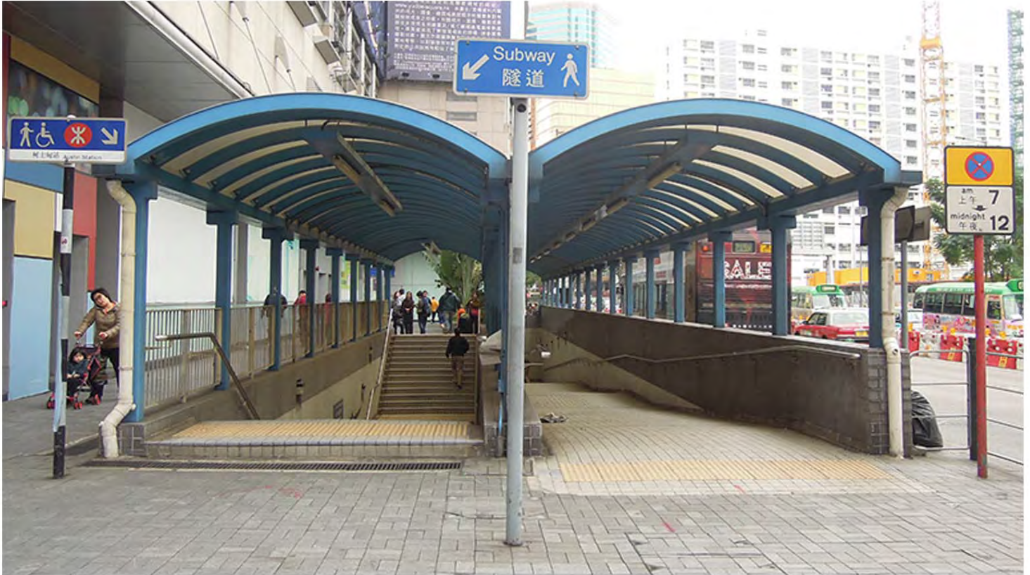
柯士甸道行人隧道近港景峰入口 - 現時狀況
