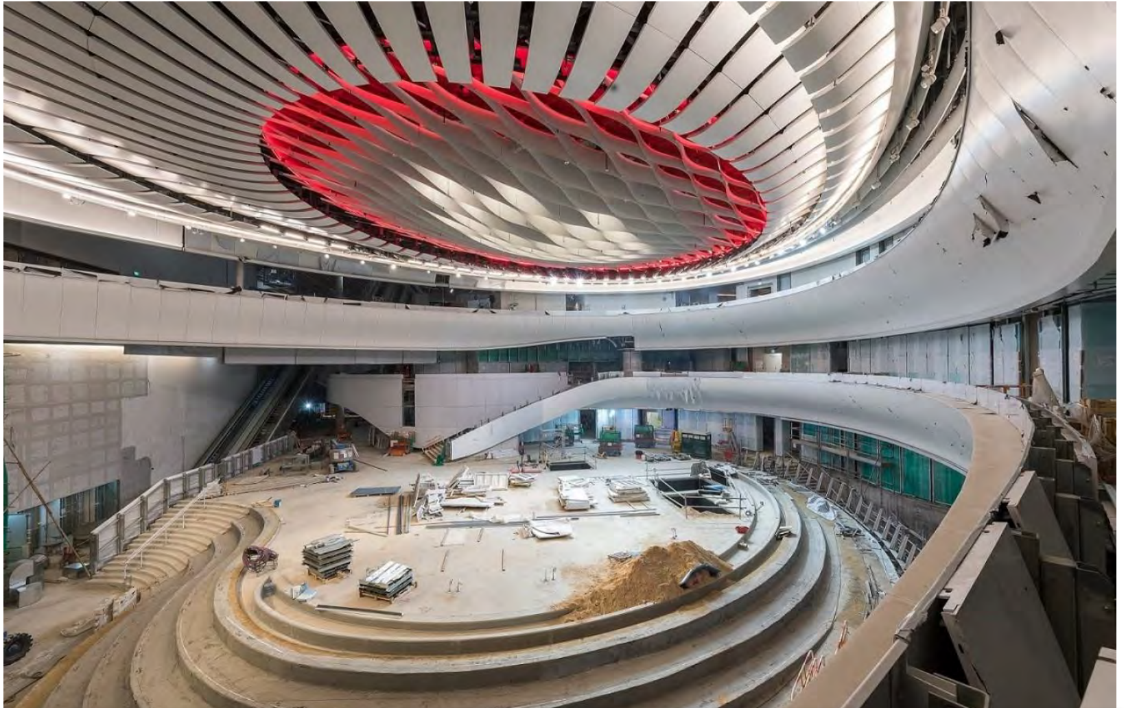
Atrium of Xiqu Centre 戲曲中心中庭
