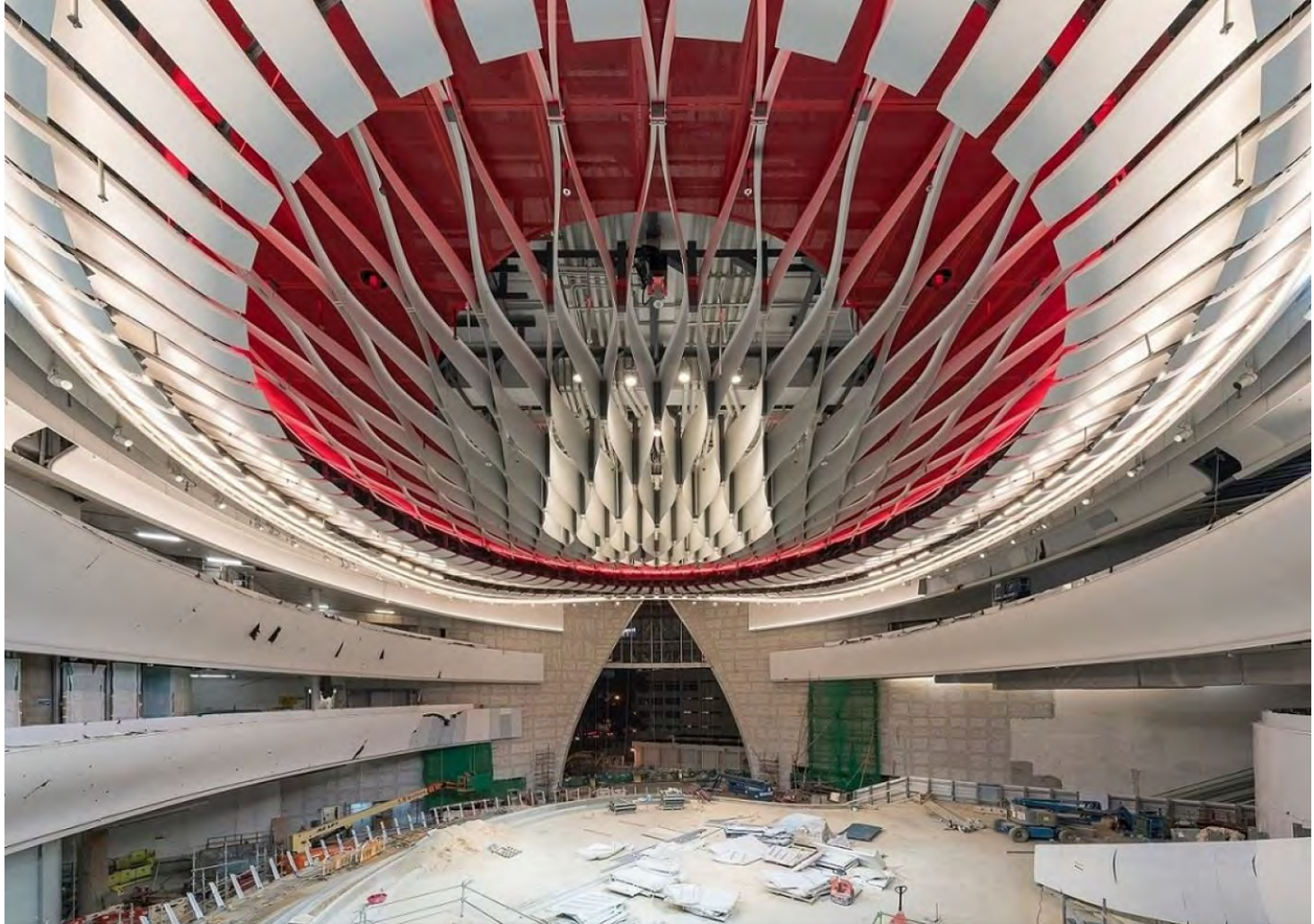
Atrium of Xiqu Centre 戲曲中心中庭
