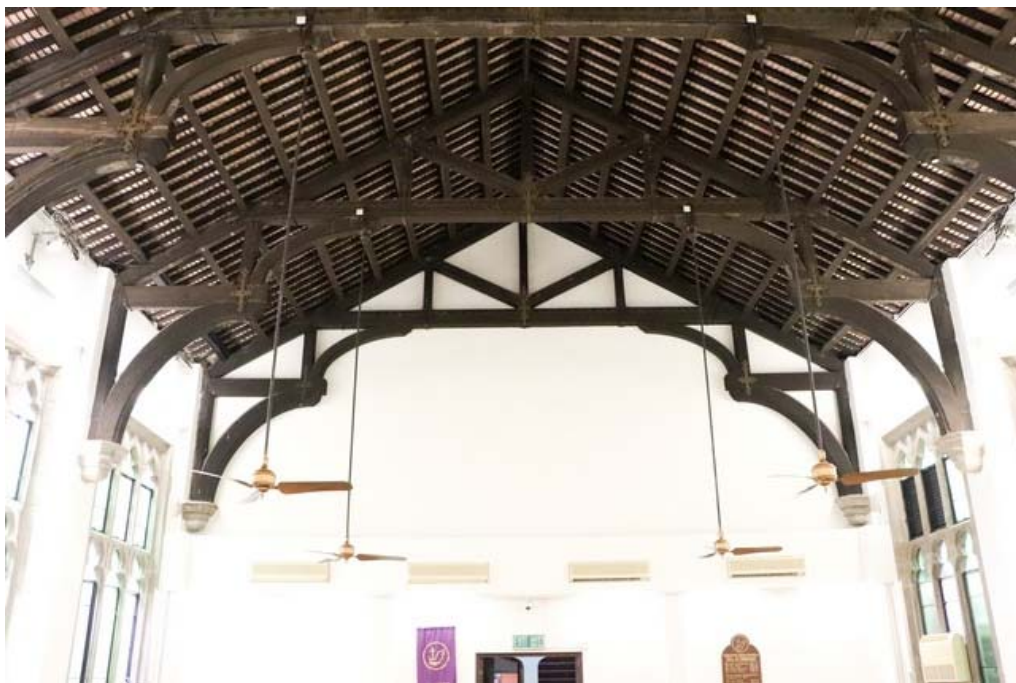
以造型優美的兩組木製托臂樑支撐屋頂桁架，加上麻石雕花樑托。
